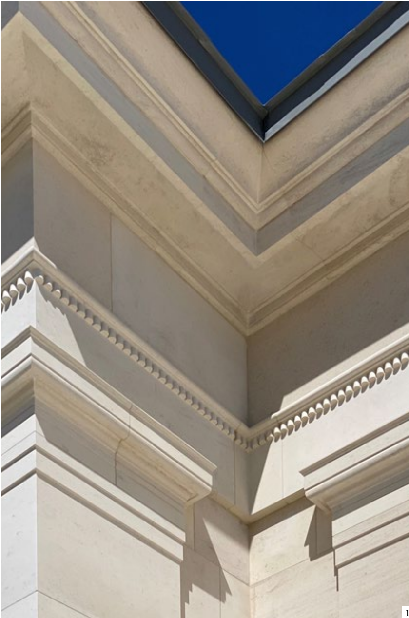
1: Memorial Court entablature (Massangis stone). 2: Execution of letter-work | 1: Entablamento del Patio conmemorativo (piedra de Massangis). 2: Realización de las inscripciones | 1: Entablamento do Tribunal Memorial (pedra Massangis). 2: Realização do inscrições
