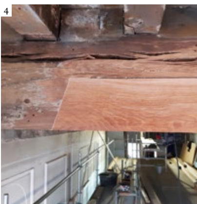
4: Joist repair (oak). 5: Replacement corbels. 6: Restored corbel | 4: Reparación de vigas (roble). 5: Ménsulas nuevas. 6: Ménsula restaurada | 4: Reparação das vigas (de carvalho). 5: Mísulas de substituição. 6: Mísula restaurada
