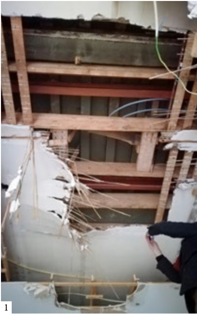
1: Double-framed ceiling behind three lower ceilings. 2: Steel reinforcement removed. 3: Restored double-framed ceiling | 1: Armadura oculta tras tres techos más bajos. 2: Refuerzo de acero retirado. 3: Armadura bidireccional restaurada | 1: Teto com armação dupla por detrás de três tetos inferiores. 2: Reforço de aço removido. 3: Tecto com armação dupla restaurado
