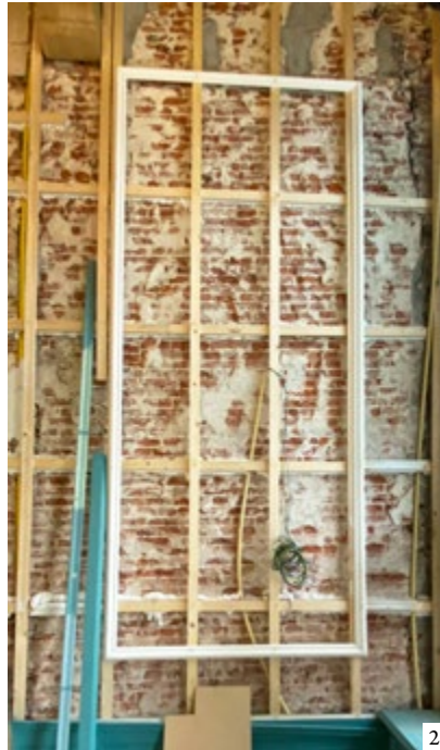
1: Paneling options. 2: Wallcovering framework. 3: Color options for paneling. 4: Color options for beams | 1: Opciones de panelado. 2: Estructura de soporte del revestimiento mural. 3: Opciones de color para el panelado. 4: Opciones de color para las vigas | 1: Opções de revestimento com painéis. 2: Estrutura do revestimento de parede. 3: Opções de cor para a colocação de painéis. 4: Opções de cor para as vigas
