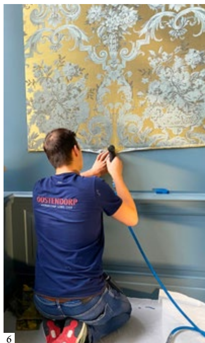
5: Flannel preparation. 6: Craftsman stretching the fabric | 5: Preparación de la flanela. 6: Artesano tensando el tejido | 5: Preparação da flanela. 6: Artesão que estica o tecido
