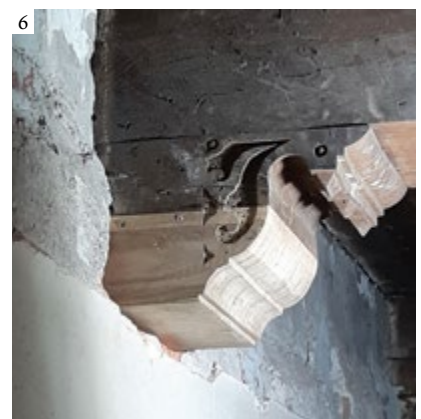
4: Joist repair (oak). 5: Replacement corbels. 6: Restored corbel | 4: Reparación de vigas (roble). 5: Ménsulas nuevas. 6: Ménsula restaurada | 4: Reparação das vigas (de carvalho). 5: Mísulas de substituição. 6: Mísula restaurada
