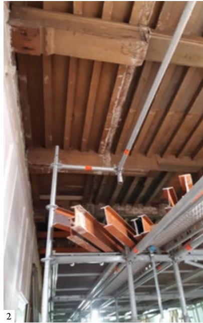
1: Double-framed ceiling behind three lower ceilings. 2: Steel reinforcement removed. 3: Restored double-framed ceiling | 1: Armadura oculta tras tres techos más bajos. 2: Refuerzo de acero retirado. 3: Armadura bidireccional restaurada | 1: Teto com armação dupla por detrás de três tetos inferiores. 2: Reforço de aço removido. 3: Tecto com armação dupla restaurado
