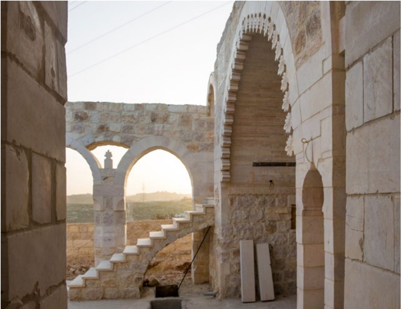
Stairway and iwan arch | Escalera y arco del iwan | Escadaria e arco do iwan
