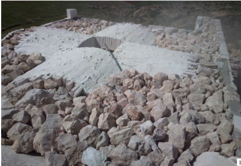
1: Construction of the loggia ceiling. 2: 75 cm stone wall filling. 3: Intersected vaulting over the kitchen. 4: Keystone at the intersection | 1: Construcción de la cubierta de la loggia. 2: Relleno del muro de 75 cm. 3: Intersección de bóvedas sobre la cocina. 4: Clave en la intersección | 1: Construção do teto da lógia. 2: Preenchimento de pedra da parede com 75 cm. 3: Intersecção das abóbadas sobre a cozinha. 4: Pedra angular na intersecção
