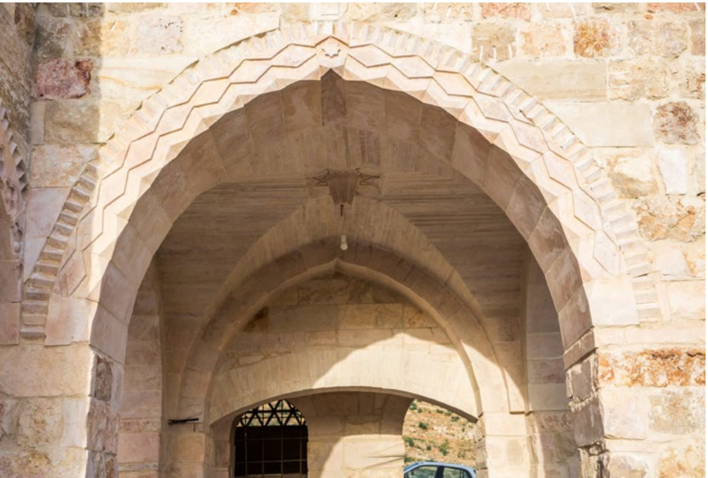
Loggia with groin-vault ceiling and ornamented outer arch | Loggia con cubierta en bóveda de arista y arco exterior ornamentado | Lógia com abóbada de aresta e arco exterior ornamentado
