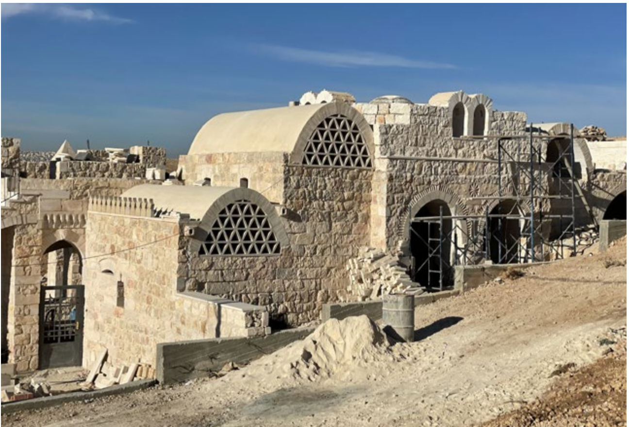
View from the street with two vaults under construction | Vista desde la calle con dos bóvedas en construcción | Vista da rua com dois cofres em construção
