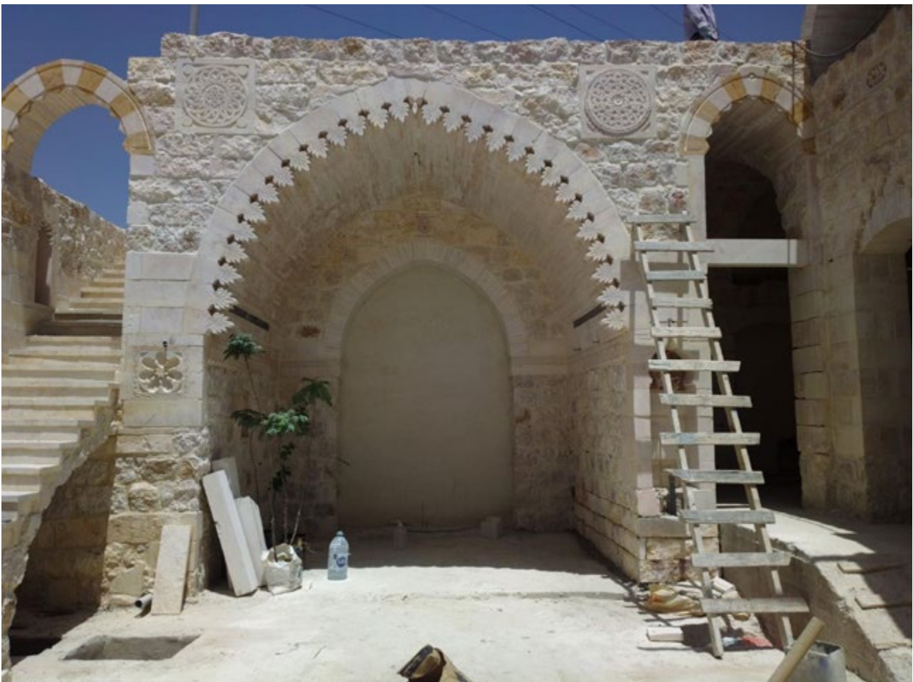
Iwan with a pointed vault and ornamental arch | Iwan con una bóveda ojival y arco decorativo | Iwan com abóbada de arco quebrado e arco ornamental
