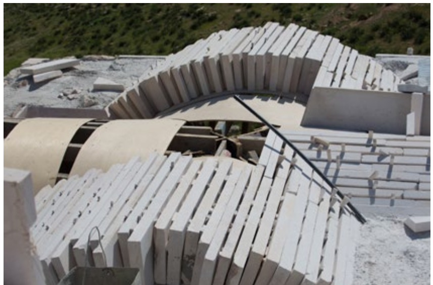
Construction of a groin vault in the loggia | Construcción de una bóveda de arista en la logia | Construção de uma abóbada de aresta na lógia
