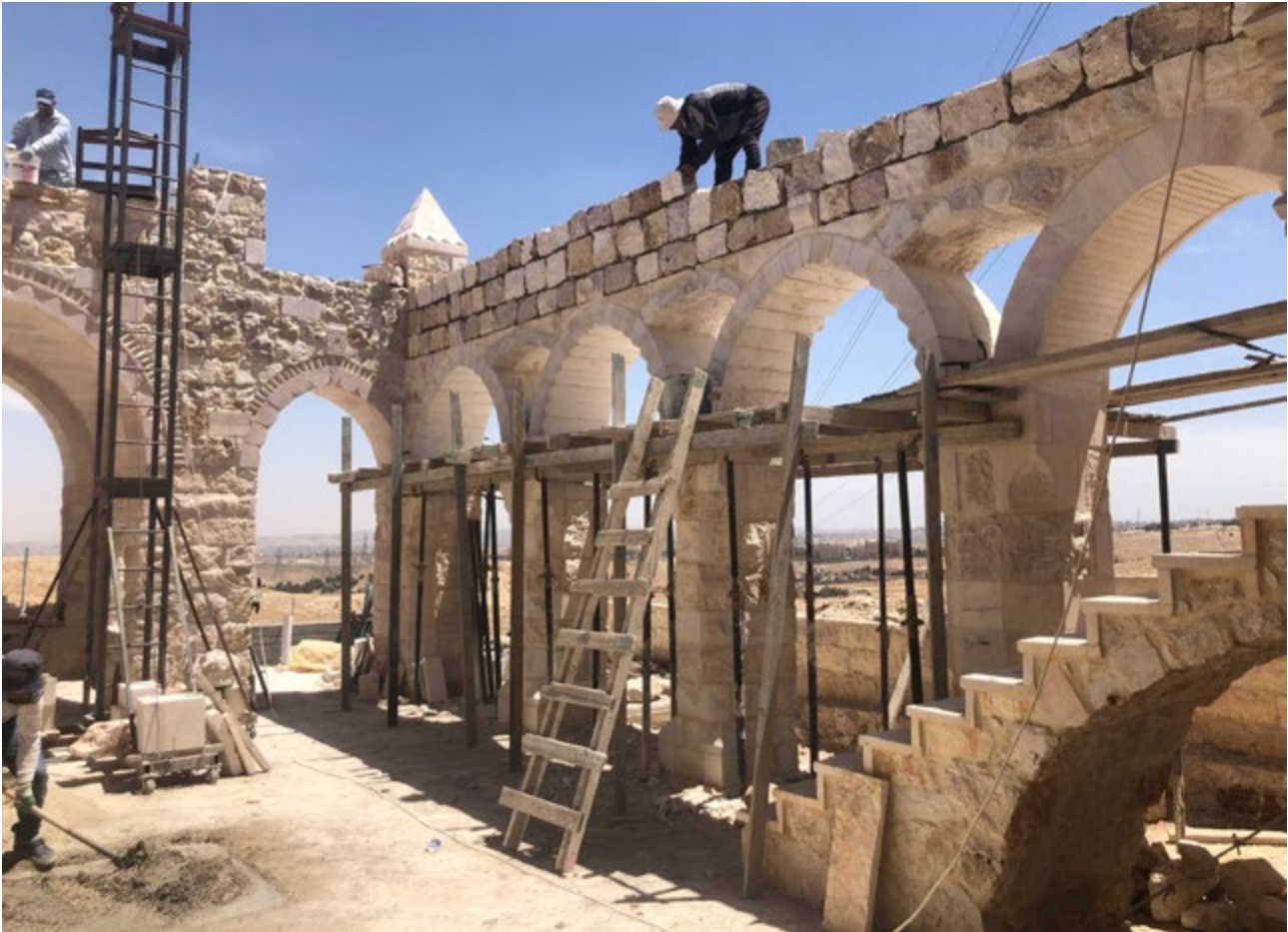
Courtyard under construction | Patio en construcción | Pátio em construção
