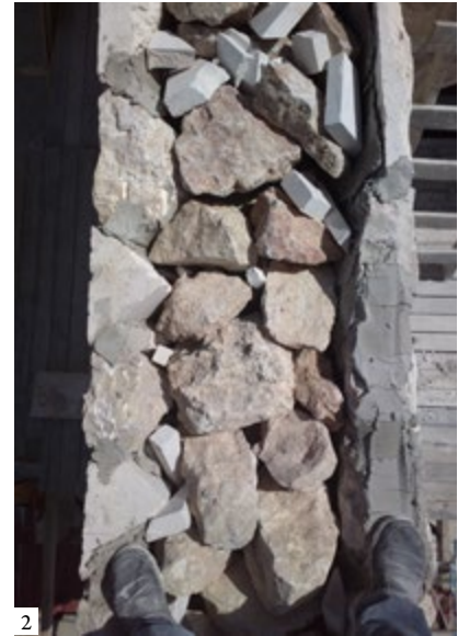
1: Construction of the loggia ceiling. 2: 75 cm stone wall filling. 3: Intersected vaulting over the kitchen. 4: Keystone at the intersection | 1: Construcción de la cubierta de la loggia. 2: Relleno del muro de 75 cm. 3: Intersección de bóvedas sobre la cocina. 4: Clave en la intersección | 1: Construção do teto da lógia. 2: Preenchimento de pedra da parede com 75 cm. 3: Intersecção das abóbadas sobre a cozinha. 4: Pedra angular na intersecção
