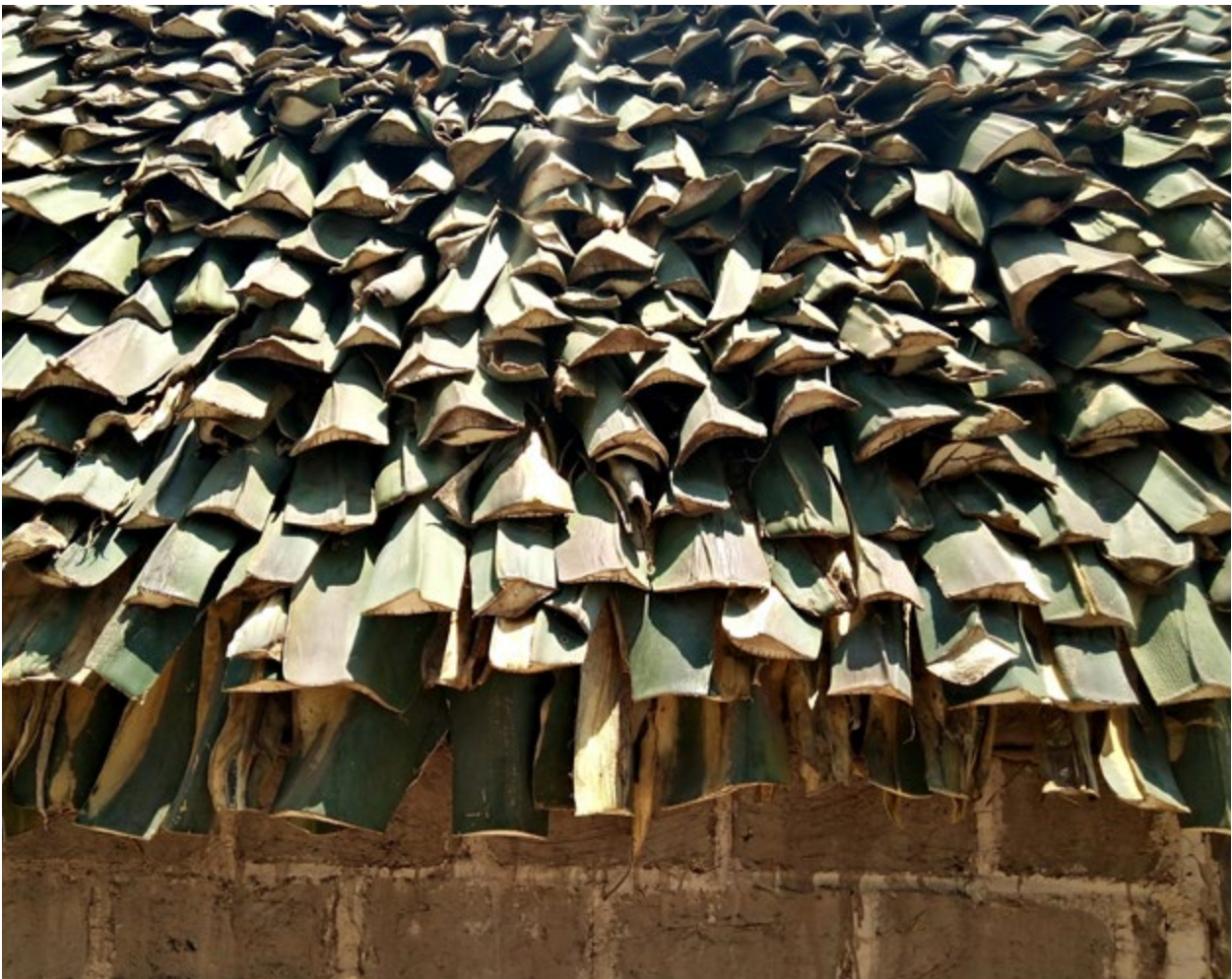
Detalle de una cubierta construida con pencas de maguey
