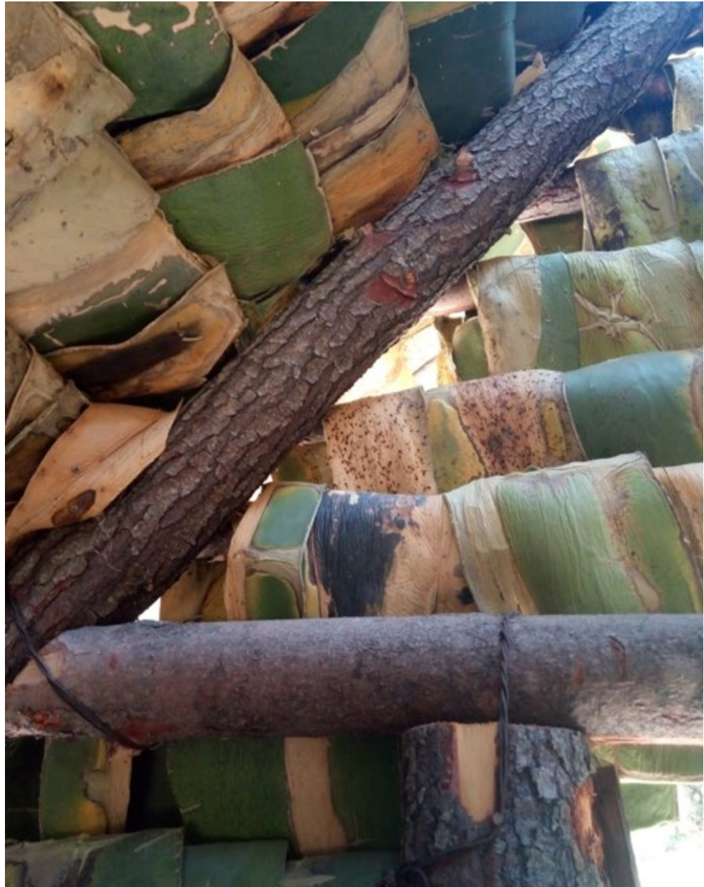
Estructura de madera de piñón de la cubierta de la cocina
