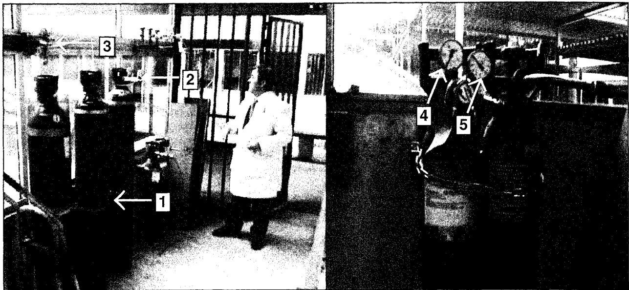
Figura 2A: Instalación exterior de gases a presión. (1) Todas las botellas se encuentran sujetas con cadenas. (2) Manorreductor simple. 3) Manorreductor doble. 2B. (4) El primer reloj marca la presión interna de la botella. (5) El segundo reloj marca la presión de salida.
