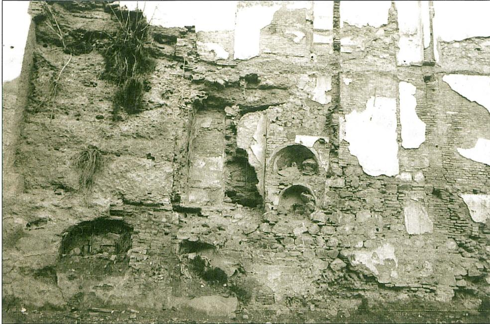
Fig. 16. Imagen de una porción de la muralla camuflada entre las medianerías de las casas situadas entre calle Carretería y Arco de la Cabeza. Fabricas de tapia de hormigón y mampostería
