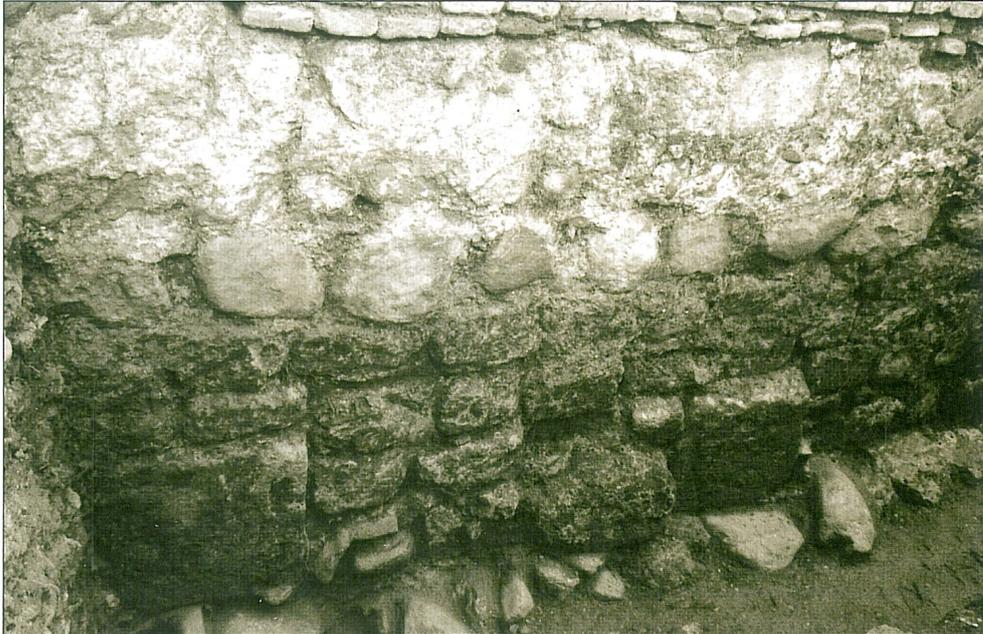
Fig. 21. Detalle de la fábrica original (siglo XI) conservada en la base de la muralla en Carretería 6-10. Sillarejos alternando entre sillares, seguido de hiladas de mampostería
