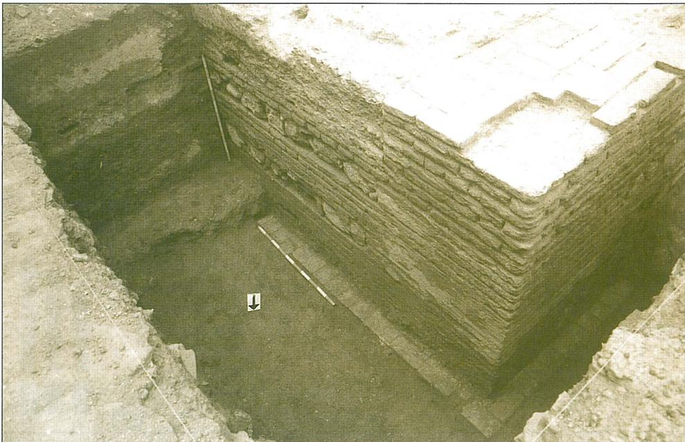
Fig. 14. Detalle de una de las esquinas de la torre aparecida en Carretería 86. Aparejo de ladrillo y mampostería. Al fondo la muralla en tapial de hormigón
