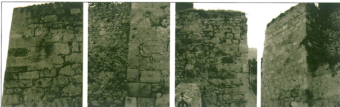
Lám. 11. Detalle de la fábrica de sillería original en los torreones 18 y 19. (Foto Oficina Arqueológica Municipal. Ayuntamiento de Antequera)
