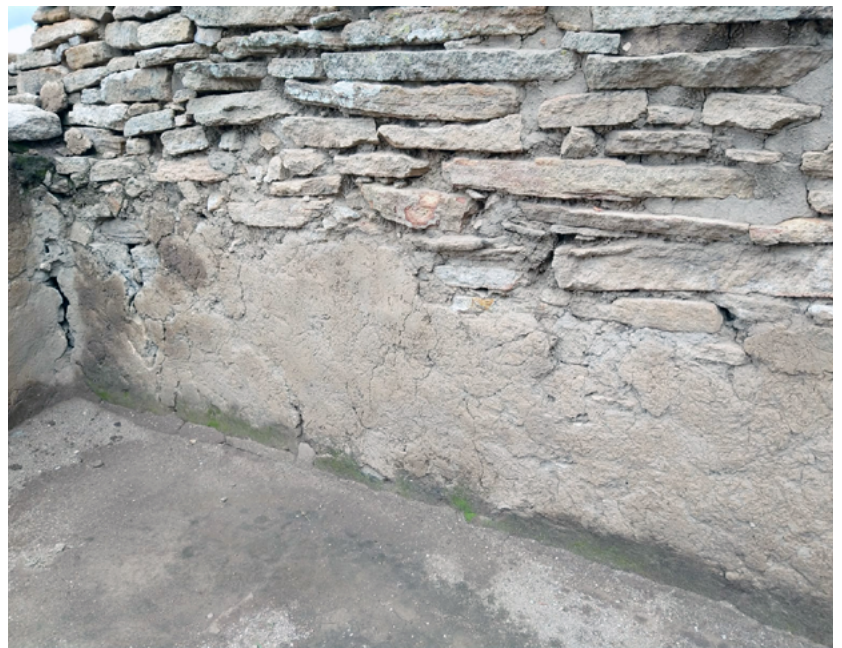
FIGURA 1. Vestigios de muro con aplanado a base de tierra en la zona arqueológica La Quemada, Zacatecas (Fotografía: Josué Israel Moreno Fraga, 2020; cortesía: Centro INAH Zacatecas).
