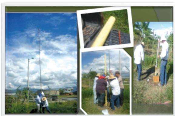
**Figura 3.** Construcción de los pozos de monitoreo -Piezómetros
