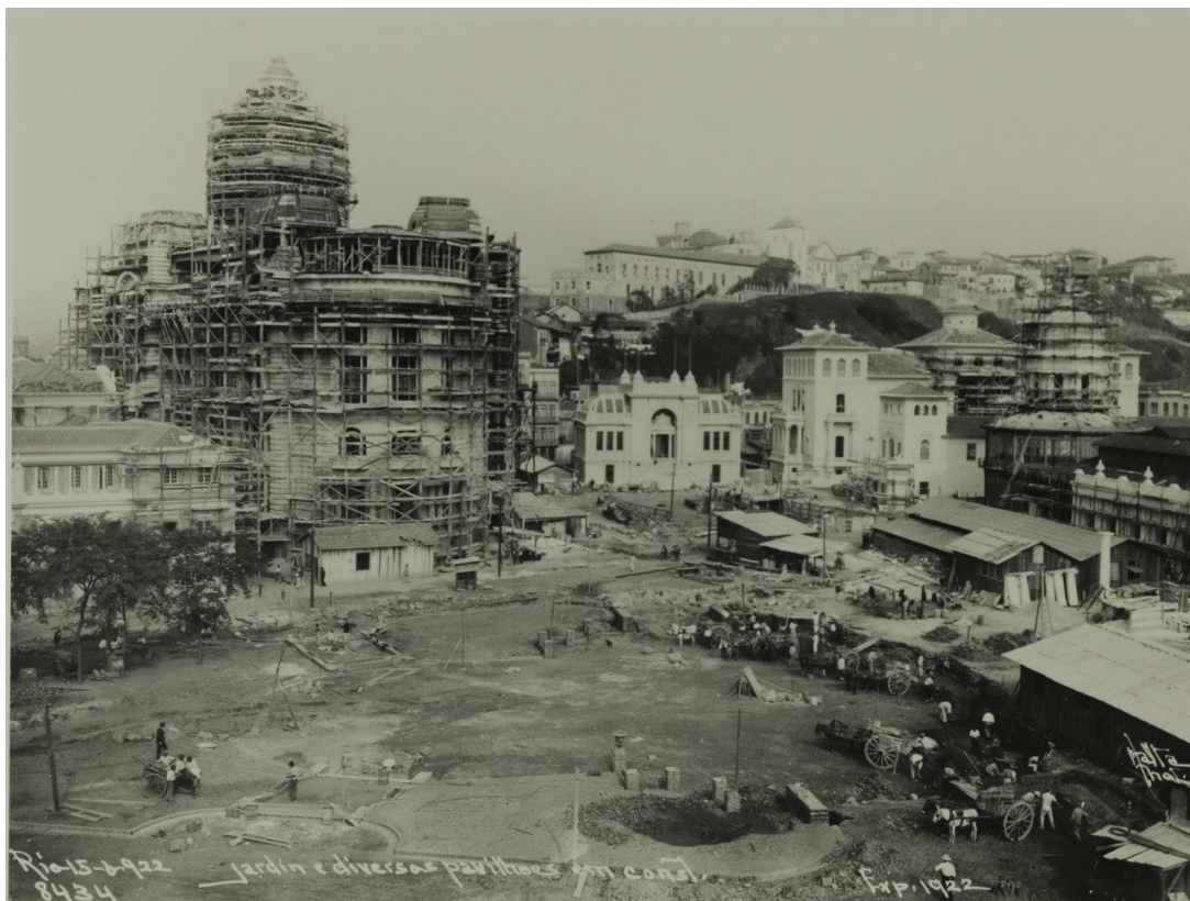
Figura 10 – Canteiro de obras e a construção dos pavilhões para a Exposição Internacional de 1922. Dentre eles, vê-se o atual prédio do MIS Praça XV.
