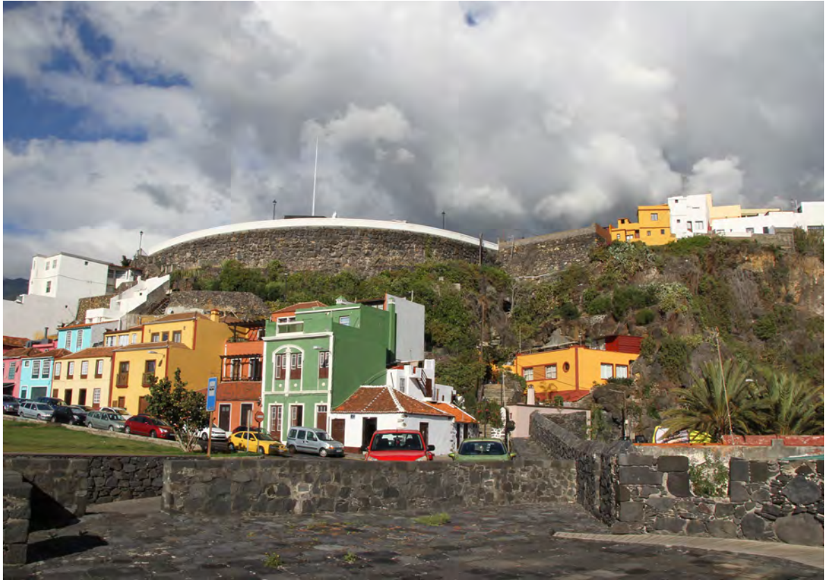
43 | Plaza de San Fernando, lomo de La Encarnación y muralla de la Portada Norte desde el castillo de Santa Cruz del barrio del Cabo; a la derecha, en tableros de madera, acceso a la batería subterránea de la fortificación, 2019. Archivo de la Oficina Técnica del Ayuntamiento de Santa Cruz de La Palma
