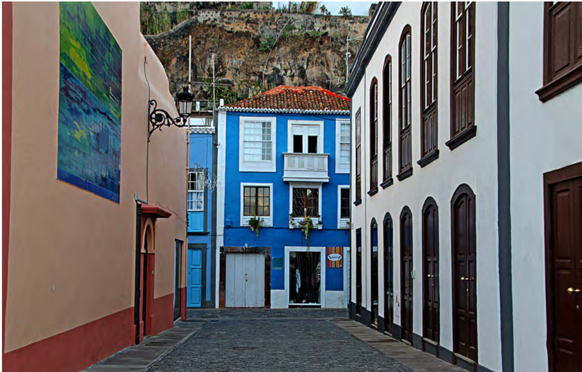
14 | Callejón Tedote, que comunica la calle Pérez de Brito con la avenida Marítima; al fondo, la casa Rocha, reedificada en su estado actual a principios del siglo XIX; su ubicación en zona principal justifica su distribución en tres plantas; en su fachada destaca la combinación de soluciones más tradicionales —como el balcón con antepecho compuesto por cuatro ventanas de celosía abatibles— con otras de introducción moderna en la época, como la ventana de guillotina, 2019. Archivo de la Oficina Técnica del Ayuntamiento de Santa Cruz de La Palma
