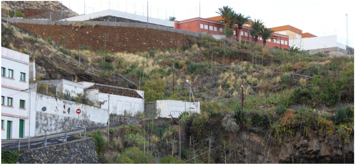
21 | Antiguo camino de La Portada, ruinas de la vivienda anexa y del cuarto de guardia, 2019. Archivo de la Oficina Técnica del Ayuntamiento de Santa Cruz de La Palma
