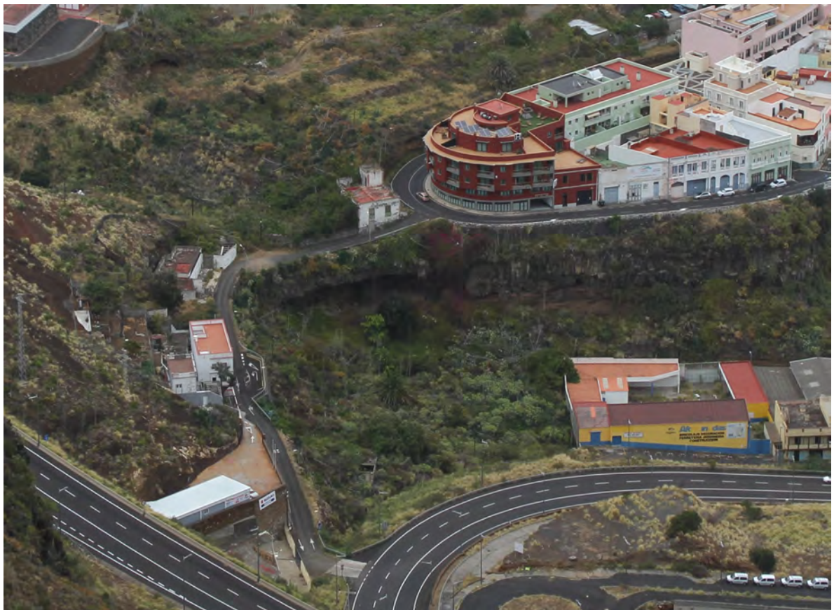
20 | Vista de la Portada Sur y del barrio de La Portada, 2019. Archivo de la Oficina Técnica del Ayuntamiento de Santa Cruz de La Palma
