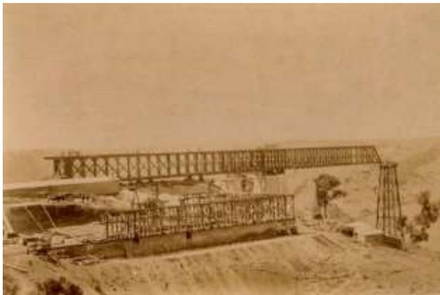
Figura 6. Estribo norte, viga armada del viaducto Malleco, 1890.
