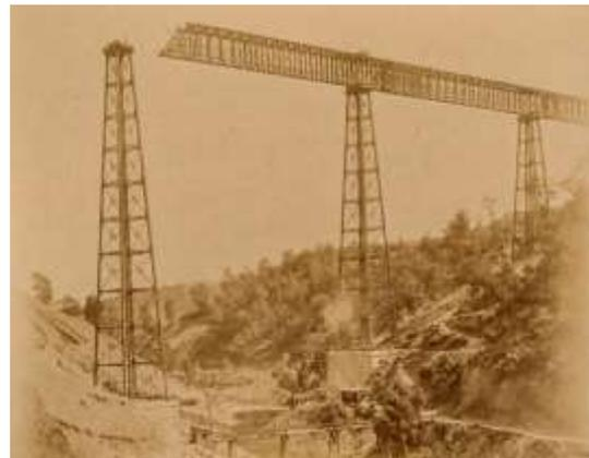
figura 7. Lanzamiento de la viga armada, 1890
