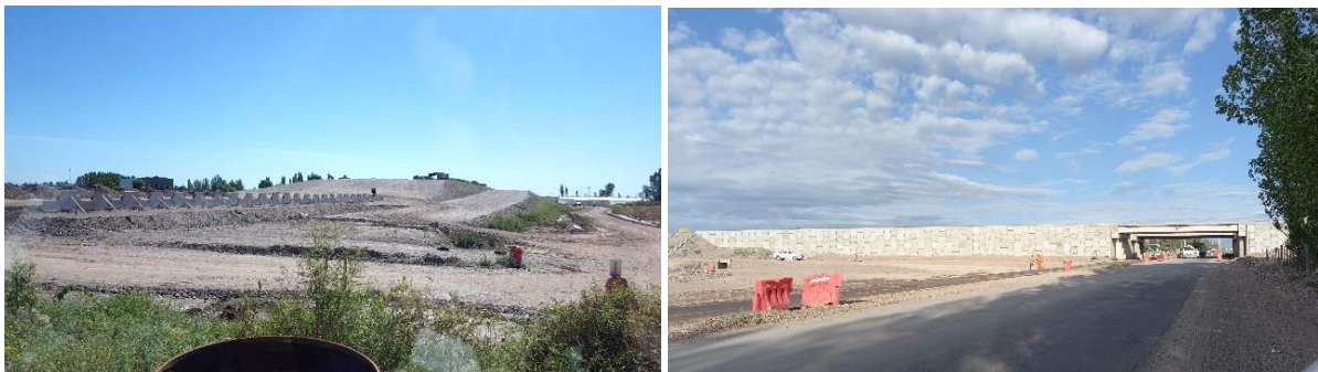
Figuras 19 y 20. Obra de la Variante Palmira en el cruce del Carril Barrancas en el año 2020 (izquierda) y 2021 (derecha).
