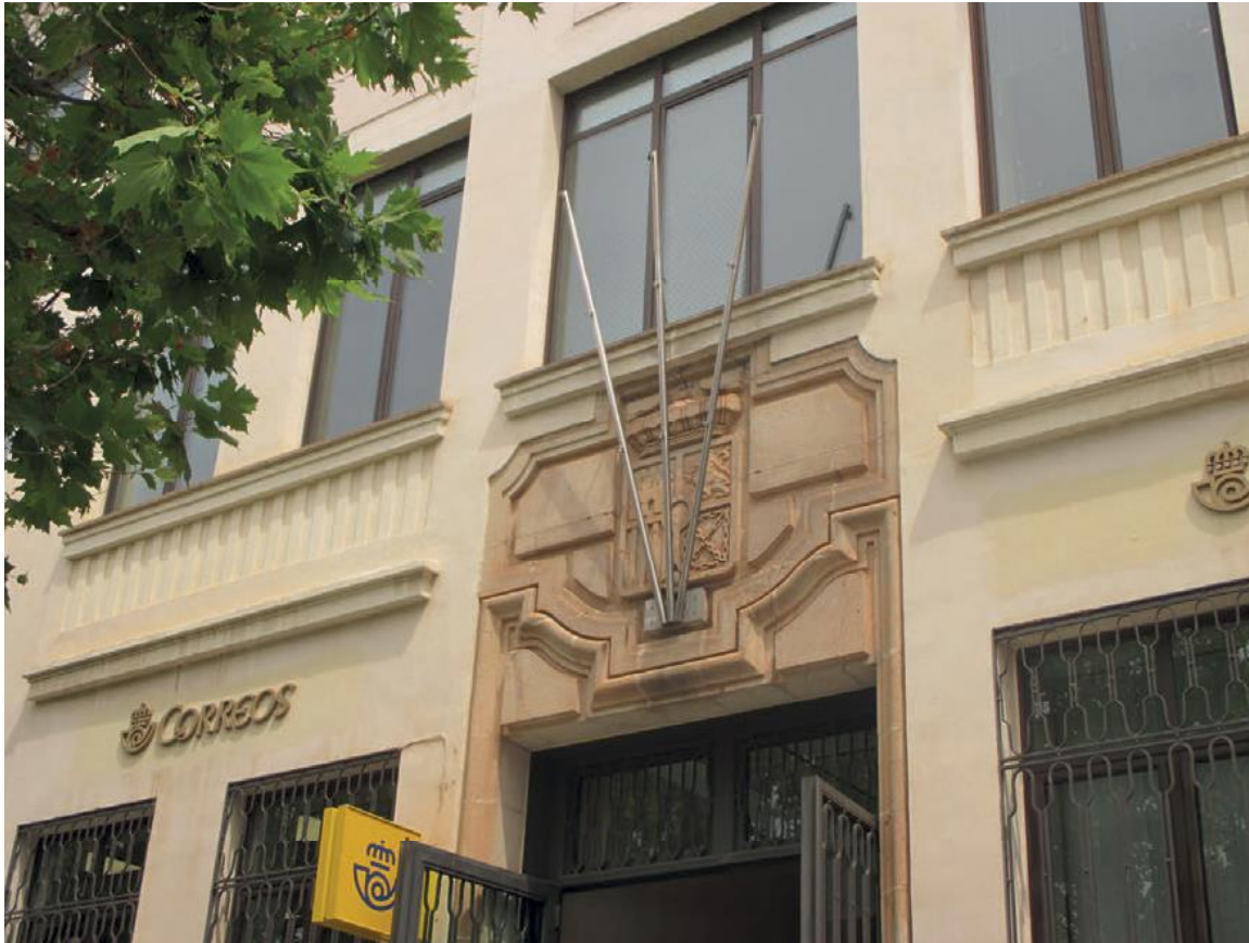
Fig. 7. Escudo de España reducido, situado en la fachada del edificio de Correos (1930), Pº del Espolón, 6, de Soria
