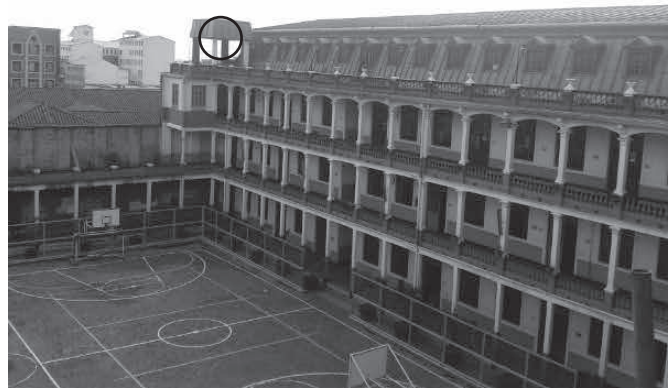
Figura 1. Sitio escogido para la instalación solar fotovoltaica en la ET-ITC.
