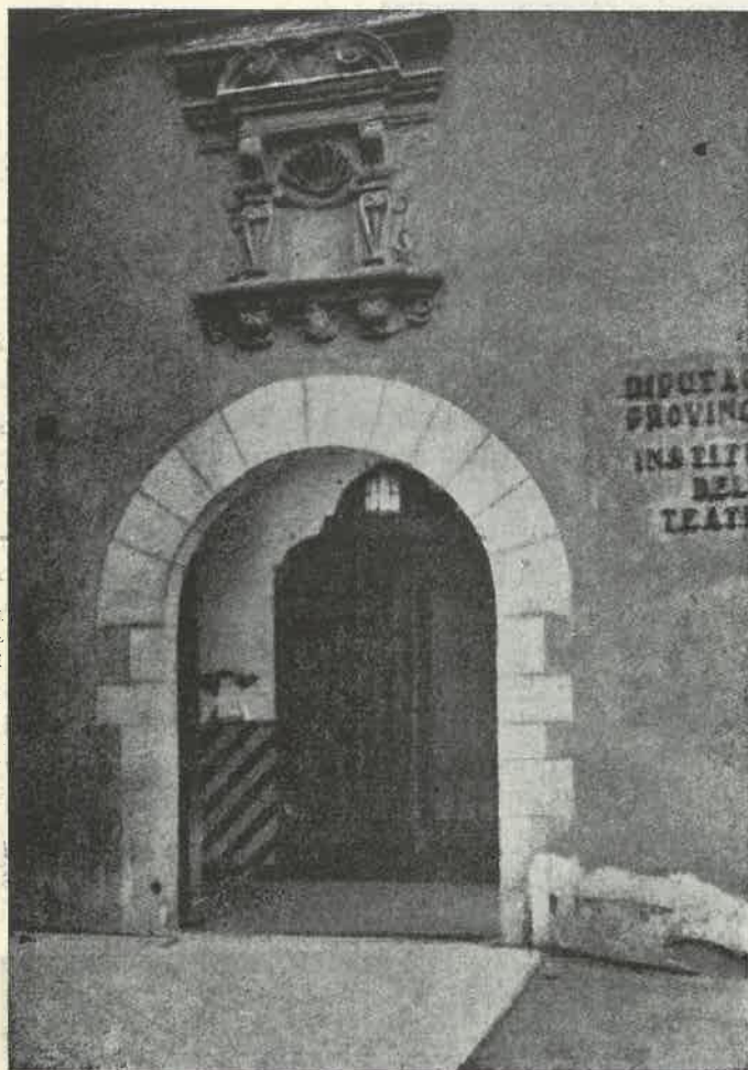
Fachada del Instituto del Teatro
