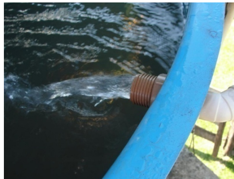
Fotografia 2 – Amostra coletada na entrada da caixa d'água
