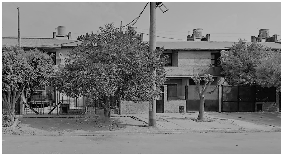
Figura 3. Primera etapa de viviendas (1999) para traslado de familias del Parque Sur. Fuente: Municipalidad de Rosario, 2017
