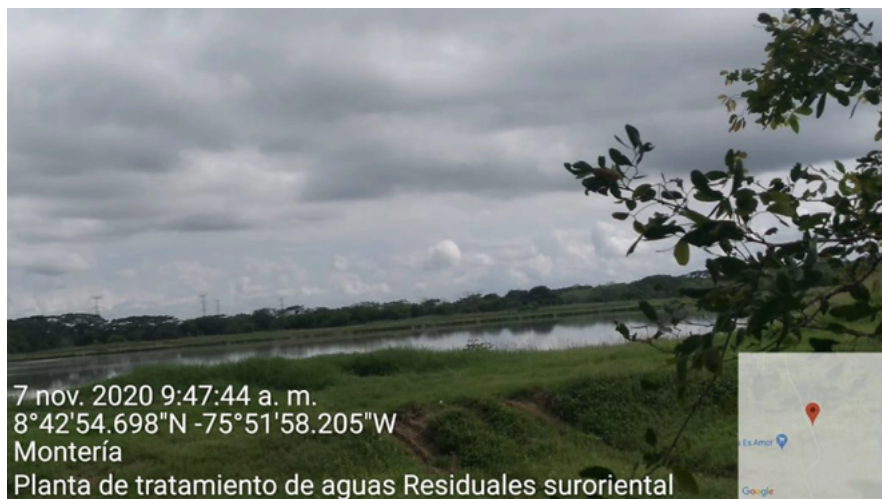
Figura 10. Poda de taludes laguna de oxidación suroriental
