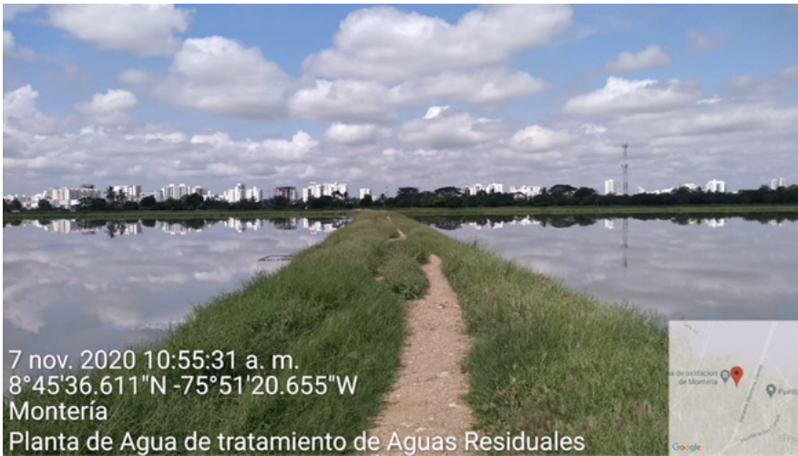
Figura 1. Planta de tratamiento de agua residual Nororiental
