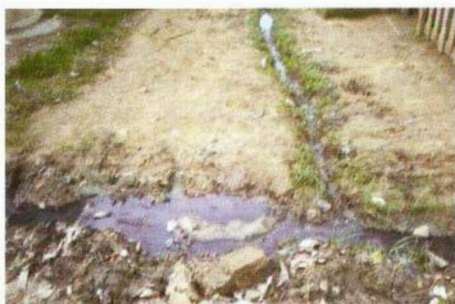
Figura 4. Concentración de aguas residuales alrededor de las vías de acceso de la población.
