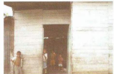
Figura 8. Condiciones de muchas viviendas de la población, estructuradas en madera.
