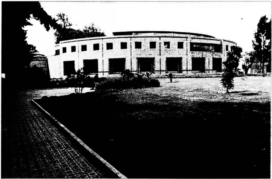
1.- Edificio de Posgrados, Facultad de Ciencias Rogelio Salmona (Fachada) Universidad Nacional de Colombia Bogotá, D. C. Foto: Fernando Ballesteros
