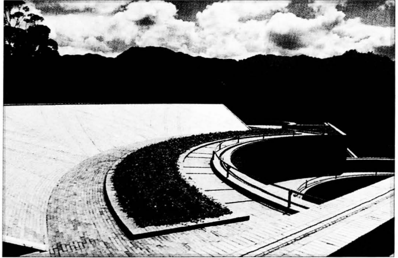
4.- Edificio de Posgrados, Facultad de Ciencias Rogelio Salmons (Vista parcial exterior) Universidad Nacional de Colombia Bogotá, D. C. Foto: Fernando Ballesteros
