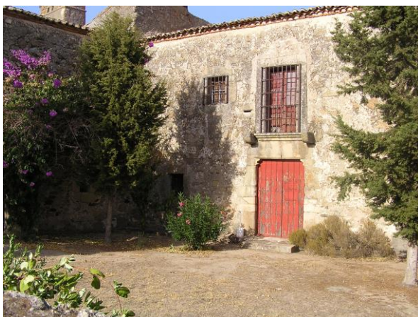
Patio y portada. Acceso desde el interior
