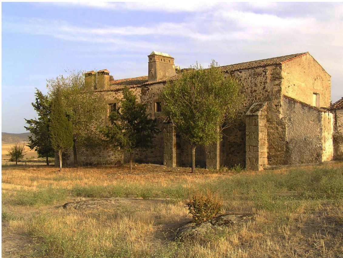
Vista de Palacio Viejo. Contrafuertes
