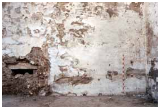
Sondeo 3 (vial). Aspecto que presentaba el Lienzo 7 antes del trazado del sondeo, con paramentos enlucidos debido al adosamiento de edificaciones actuales. A la izquierda, sondeo parietal que ha dejado al descubierto la poterna que enlaza con el interior del castillo.
