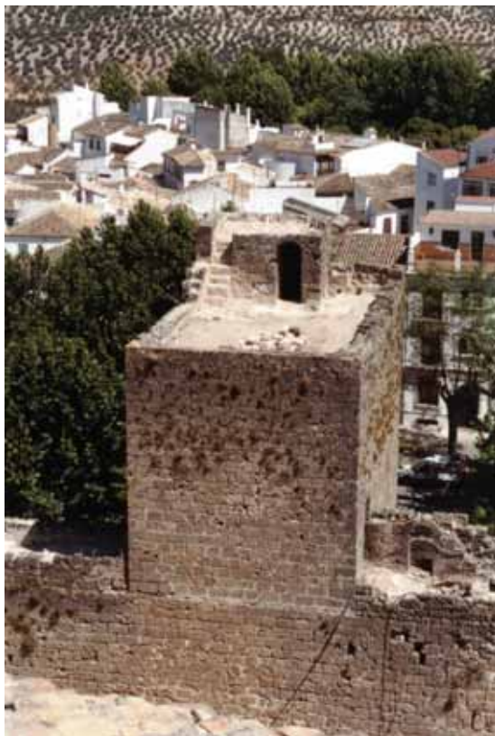
Torre 2 (siglo XV). Panorámica general, durante la terminación de los trabajos, vista desde la torre del homenaje.
