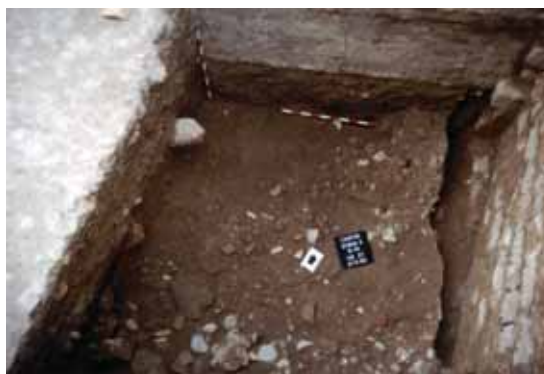
Sondeo 15 (Z5). Sondeo en fase de excavación, con zanja a la derecha relacionada con la reconstrucción del Lienzo 9. Al frente, el Lienzo 12.
