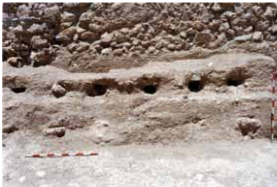
Zona 7. Lienzo 4 (lado NW). Detalle de la fase correspondiente a la obra bajomedieval en tapial.
