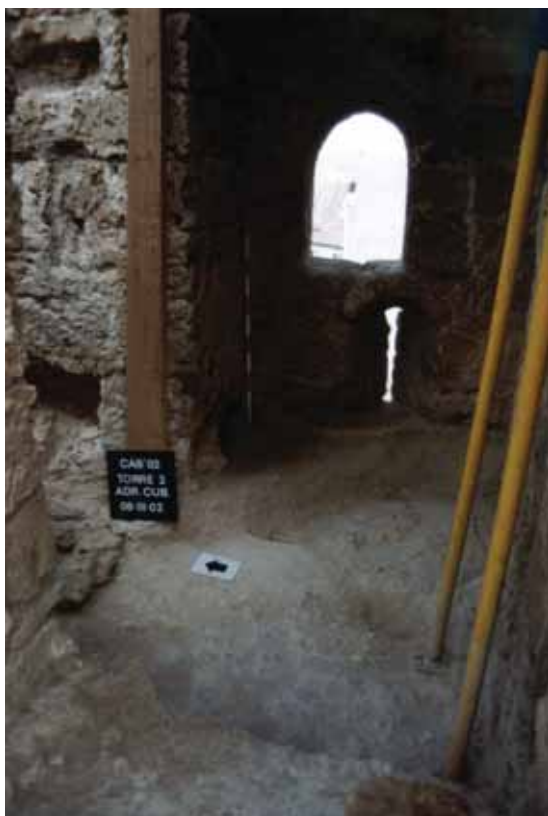
Torre 3. Adarve cubierto. Detalle. La ventana y la aspillera se han liberado de la obra que cegaba los vanos.
