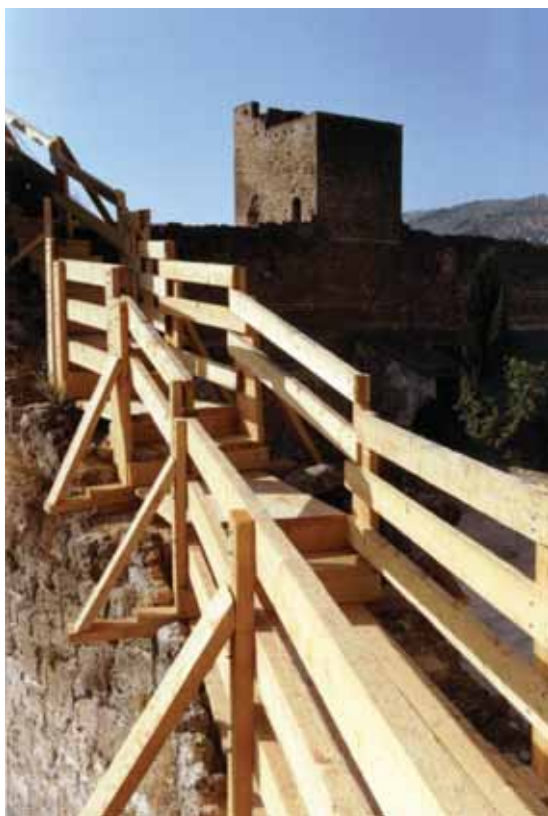
Lienzo 3. Sistema de pasarelas ideado para posibilitar la visita provisional al público. La estructura de madera de superpone a la obra medieval, mediando una protección de geotextil y gravilla, sin anclaje de ningún tipo.
