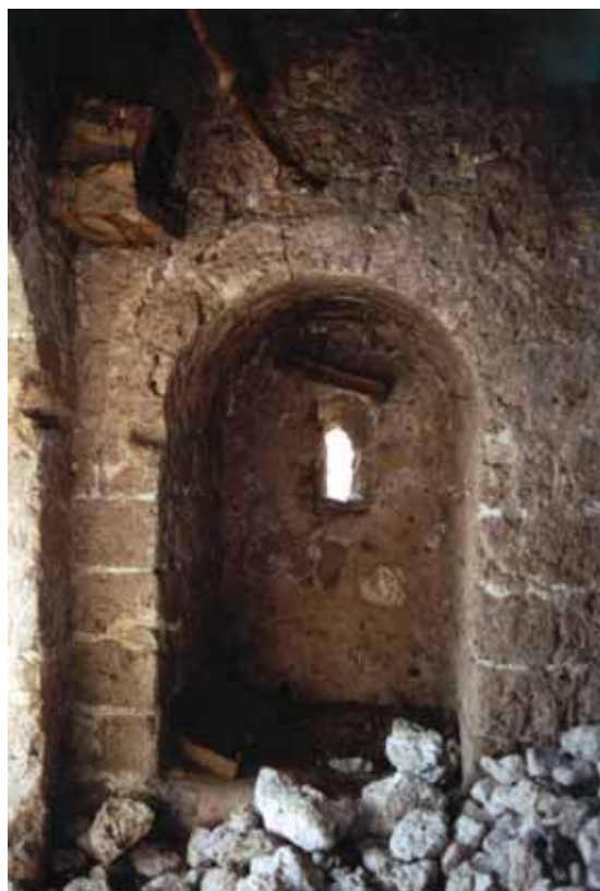
Torre 2. Ejemplo de cámara de tiro con aspillera condenada por muro postmedieval, antes de su eliminación.
