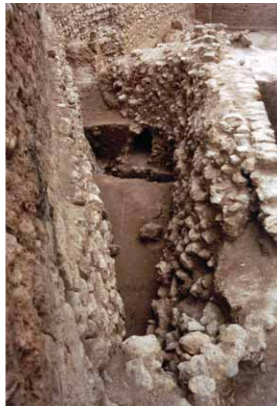
Sondeo 14 (Z6). Panorámica de la Zona 6 donde se trazó el sondeo junto al Lienzo 9 (al fondo, con salida de cañonera). A la derecha, el Lienzo 12, descostrado, y a la izquierda, el Lienzo 5 (muro de contención postmedieval).
