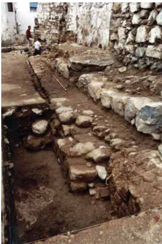
Sondeo 2 (vial). Lateral derecho del pasillo cubierto bajomedieval al que se accede desde la puerta andalusí documentada, y que se configura como un engrosamiento del Lienzo 6. Para su construcción se ha empleado una fábrica de sillería de travertino (U.E. 29).
