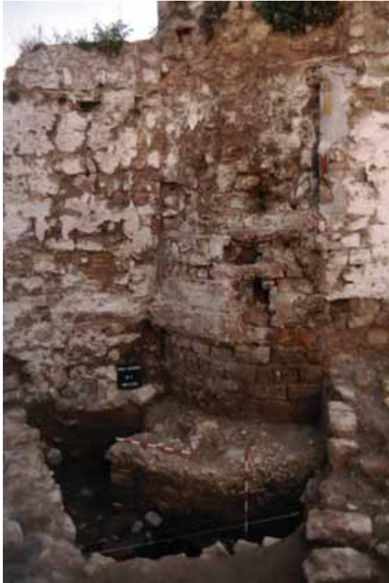
Sondeo 1 (vial). Aspecto de la Torre 8, con alzado bajomedieval de sillería descostrada y migajón al descubierto, y, debajo, fase andalusí de la misma (tapial).
