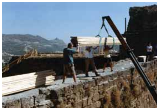
Lienzo 2. Subida de tablonas hasta el adarve con el objeto de habilitar un itinerario para la visita al público.
