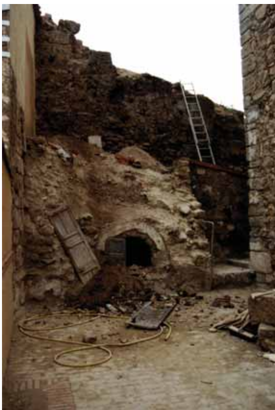
Zona 1. Sector situado entre la poterna y el aljibe, fuertemente parasitado por estructuras postmedievales, visto desde el terrado del segundo, en el momento de comienzo de la intervención, tras realizar una retirada del escombros acumulado tras un derrumbe provocado por efecto de las lluvias invernales.
