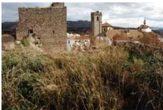
Torre 1. Detalle antes de la intervención.
