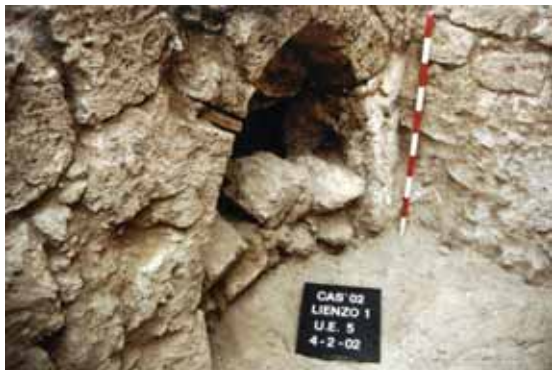
Lienzo 1. Detalle, en proceso de excavación, del paso abovedado de acceso directo al adarve del lienzo, desde el interior de la fortificación.
