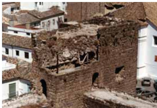
Torre 3 (siglo XV). Vista aérea desde la torre del homenaje. Esta torre se encuentra parcialmente desmantelada, en su adarve cubierto de acceso, desde la década de los setenta del siglo XX.
