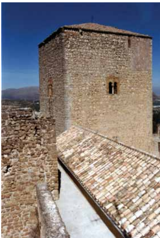
Lienzo 8. Panorámica general del lienzo una vez finalizados los trabajos. A la izquierda, la Torre 6 y, al fondo, el homenaje.
