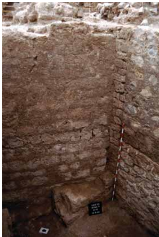
Sondeo 15 (Z5). Detalle de la unión entre los lienzos L9 (izquierda) y L11 (derecha). El contrafuerte, y el tramo inferior de muralla a su derecha, pertenece a una fase andalusí de época omeya.
