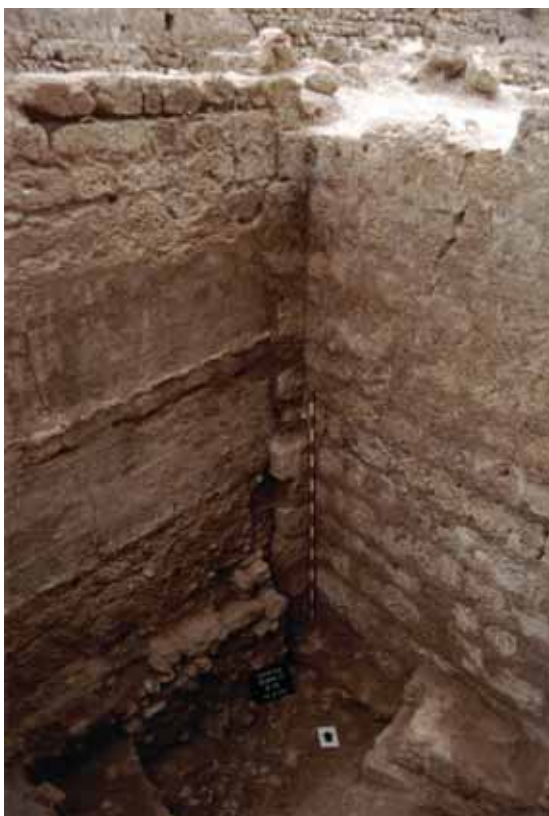
Sondeo 15 (Z5). Detalle de la unión entre los lienzos L12 (izquierda) y L9 (derecha).
