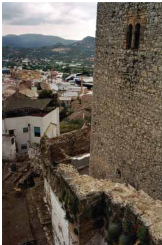
Intervención en el exterior del castillo. Relación entre la torre del homenaje y el sector del vial peatonal.
