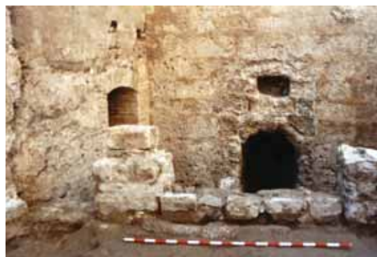
Zona 1. Vista parcial del Lienzo 7, esquina con el edificio adosado a los lienzos L7 y L8, una vez retiradas las estructuras postmedievales parasitarias adosadas. Al frente, poterna medieval.
