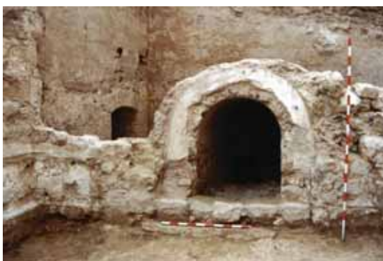
Zona 1. Desmantelamiento progresivo de estructuras postmedievales, edificadas como soporte de la rampa de acceso a la segunda planta del edificio (siglos XVII-XVIII) adosado a los lienzos L7 y L8. Al fondo, a la izquierda, comienza a dejarse al descubierto un acceso original a dicho edificio. En primer término, paso abovedado postmedieval que comunica con la poterna medieval, condenada.
