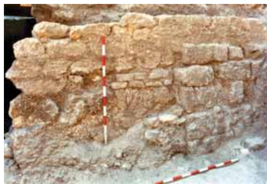
Zona 5. Lienzo 11. Superposición de la fase bajomedieval cristiana (sillaretes con mortero de cal) sobre la andalusí de época omeya (sillería a soga y tizón y mortero de yeso).
