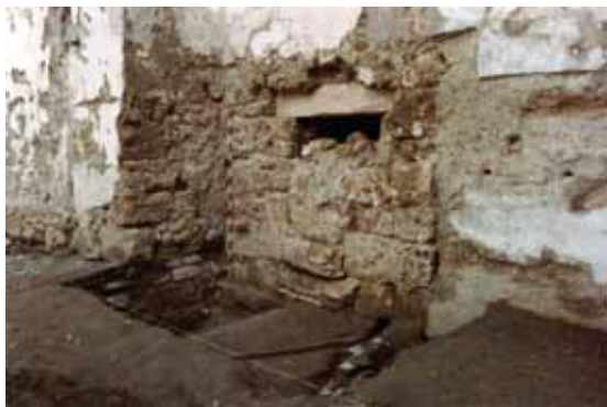
Sondaje 3 (vial). Localización del sondeo en la unión de la Torre 5 con el Lienzo 7. La poterna, aún tapiada, presenta como dintel un gran bloque de caliza blanca oolítica con una inscripción latina conocida desde el siglo XVI (CIL II 2 /5, 273). A la derecha se observa la fase del lienzo de época andalusí (tapial de hormigón).
