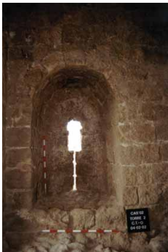
Torre 2. Cámara de tiro una vez eliminado el muro que condenaba su aspillera.
