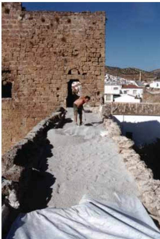
Lienzo 2. Una vez terminada la intervención, los adarves, terrazas de torres y demás estructuras frágiles de la fortificación fueron cubiertos con geotextil y gravilla, sobre los cuales se habilitaría el sistema de pasarelas para la visita provisional al público.
