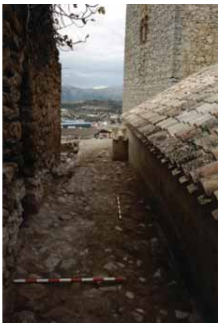
Lienzo 8 y 7. Detalle del empedrado perteneciente a uno de los dos pavimentos documentados en el adarve, justo en el acceso a la Torre 6.
