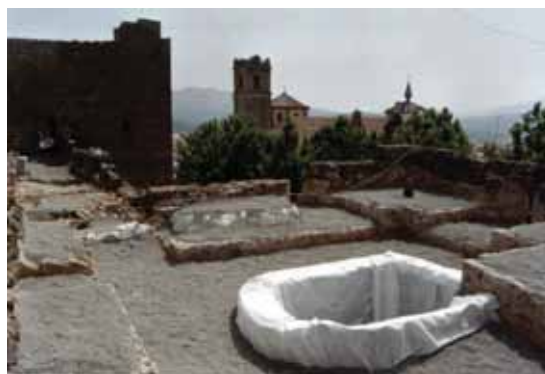
Torre 1. Detalle después de la intervención, con las superficies protegidas con geotextil y gravilla.
