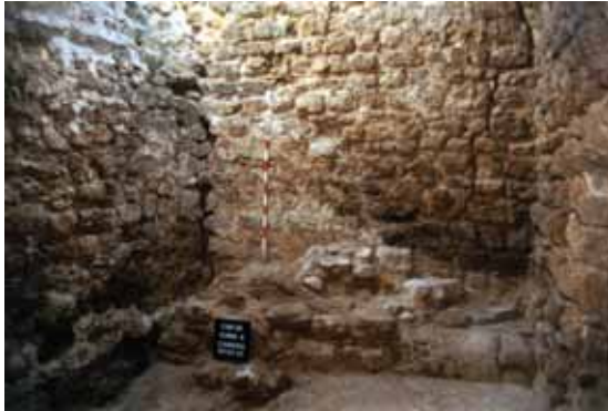
Torre 6. Cámara de habitación. Localización, tras la intervención, de las escaleras de acceso a la terraza.
