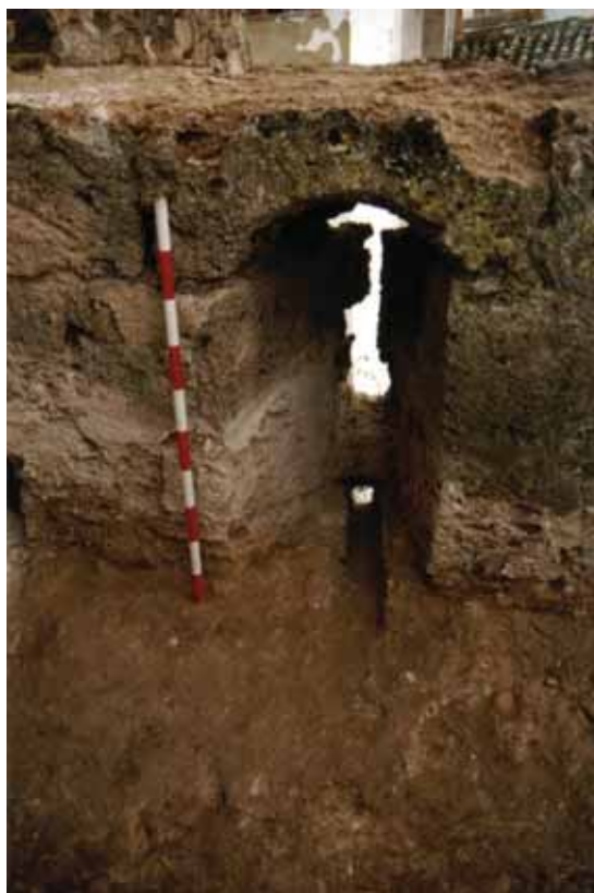
Lienzo 8. Tronera (¿antigua aspillera adaptada?) conservada, una vez desprovista de los añadidos postmedievales que desvirtuaban su apariencia. El pavimento asociado, de mortero de cal, es el original, así como el sistema de evacuación de aguas.
