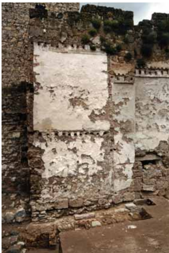
Sondeo 2 (vial). Torre 5, parasitada por edificaciones adosadas derribadas.
