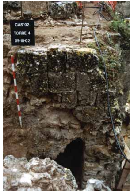
Torre 4. Detalle del lateral derecho de la caja de escalera que permitía el enlace entre el Lienzo 10 y el Lienzo 3, después de la colmatación medieval del interior de la cámara de habitación de la torre, inutilizándola.
