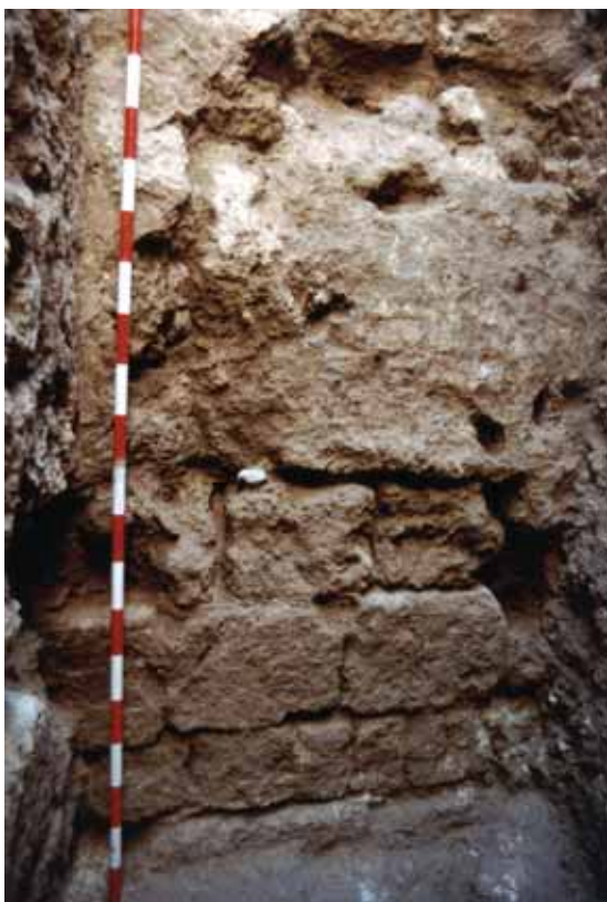
Sondeo 14 (Z6). Detalle del Lienzo 11, en su unión con el Lienzo 9. Sobre la sillería (compartida con el Lienzo 9) aflora la roca natural (travertino) y sobre ésta la fase de tapial, la más antigua de las documentadas en este lienzo.
