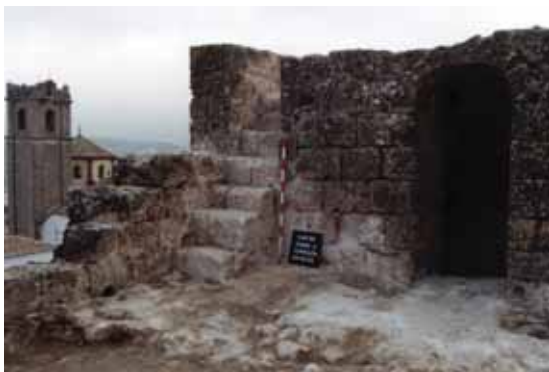
Torre 2. Terraza. Garitón de salida de la escalera de acceso a la terraza, aprovechado como espécula para vigilancia. Durante la intervención se han recuperado las escaleras originales de subida a la espécula.
