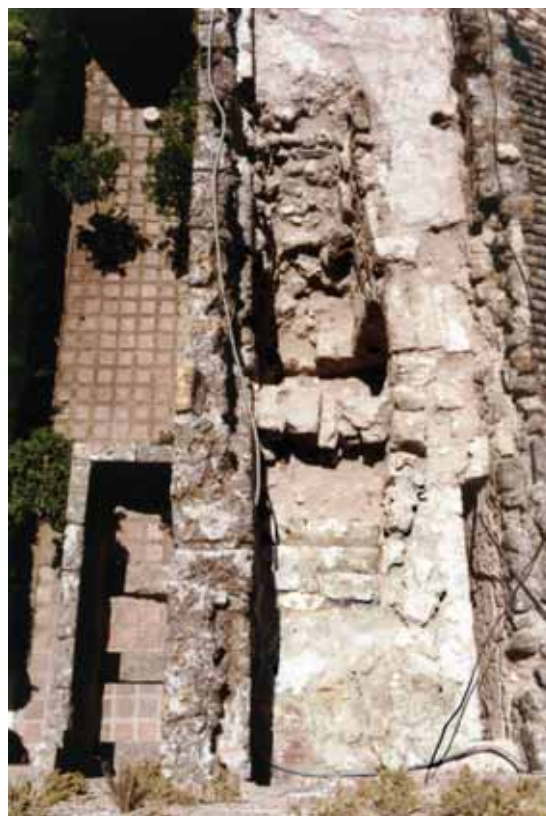
Lienzo 1. Sector del acceso escalonado directo (siglo XV, finales) al adarve de este lienzo desde el interior del castillo, visto desde la terraza de la Torre 2. Abajo, a la izquierda, la ladronera; y a la derecha, la mortaja del rastrillo.
