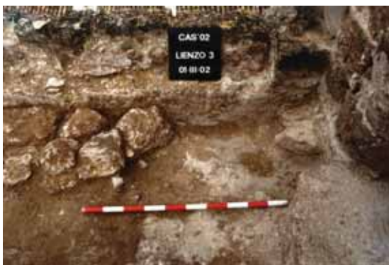
Lienzo 3. Pavimento original del adarve (siglo XV), de mortero de cal.
