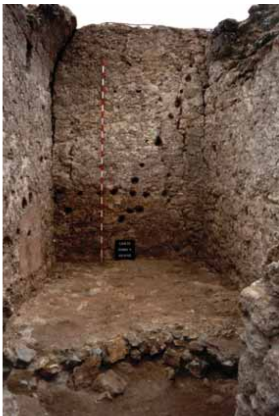
Torre 4. La cámara de habitación una vez finalizados los trabajos de evacuación de los rellenos de colmatación que la inutilizaban, vista desde la zona de la entrada (Lienzo 10). Los mechinales corresponden al sistema de subida a la terraza, con estructura de madera.
