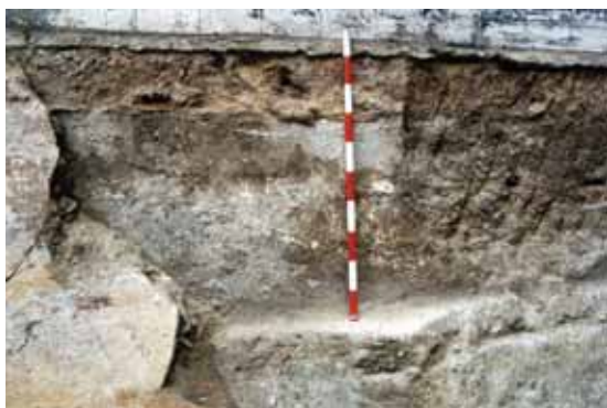
Sondeo 5 (vial). Detalle del Lienzo 8, fase de tapial.
