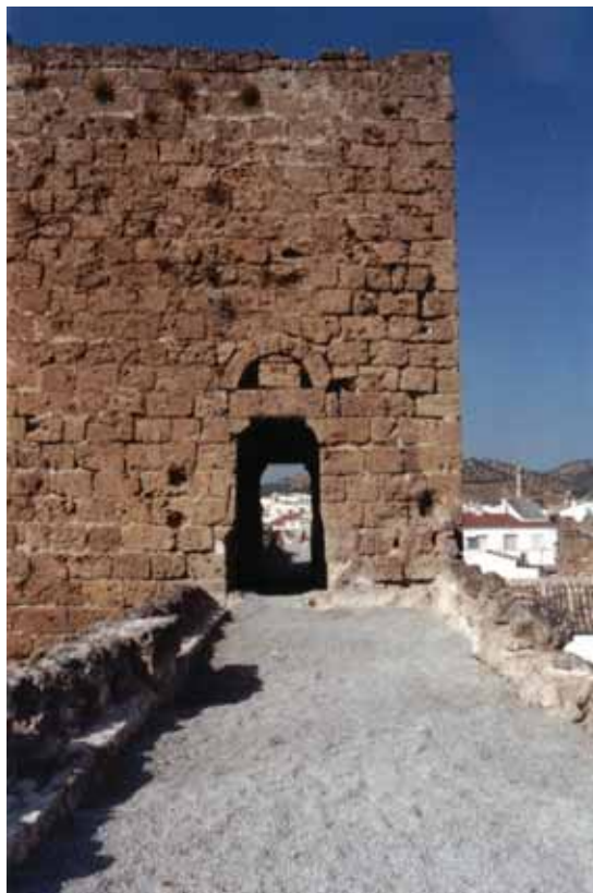
Torre 2. Acceso, desde el Lienzo 2, a su cámara de habitación, durante la finalización de los trabajos.
