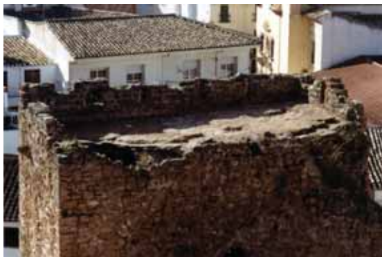
Torre 6 (finales siglo XIV). Panorámica general de la terraza, en proceso de finalización de los trabajos. Conserva buena parte del parapeto original, así como el arranque de la merlatura.
