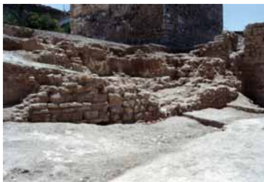
Zona 7. Lienzo 10. Obra perteneciente a la almazara postmedieval (siglos XVI-XVII), coincidente, en alineación, con la muralla.
