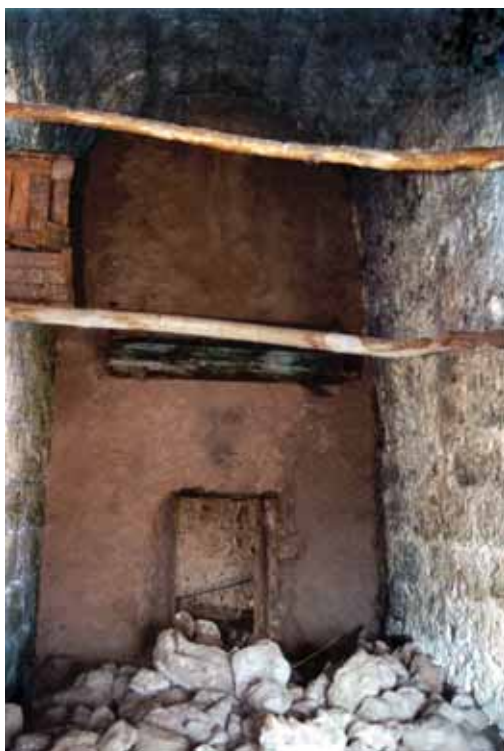
Torre 2. Interior antes de la intervención, con numerosos elementos distorsionadores postmedievales: escombro, muros divisorios, vigas, palomares, etc.
