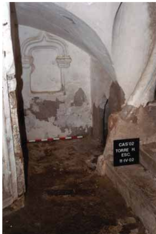
Torre del homenaje (1246-1327). Planta Primera. Sector postmedieval intervenido que une las dos plantas en las que se encuentra subdividida la planta Primera de la torre. Antes de la intervención.
