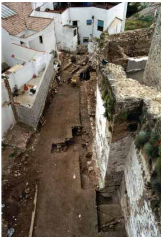
Intervención en el exterior del castillo. Vista parcial del espacio obtenido tras los derribos, desde la terraza de la Torre 6. Se identifican los Sondeos 1, 2 y 3.
