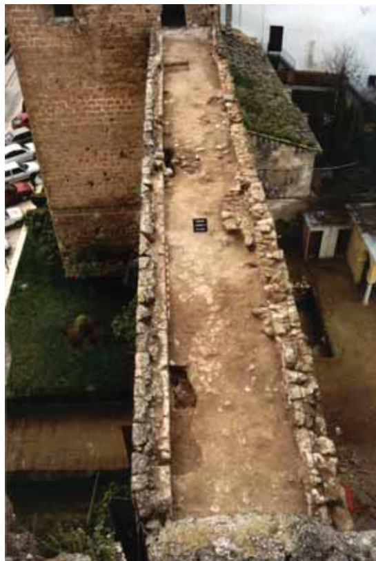
Lienzo 2. Panorámica general durante la finalización de los trabajos, con los diversos pavimentos documentados, parapeto, aspilleras y paradós.
