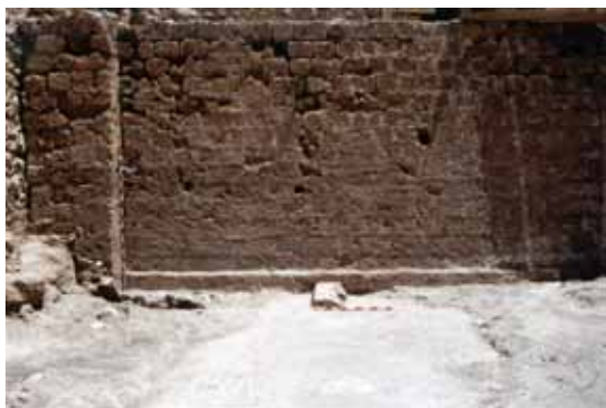
Zona 7. Lienzo 4 (lado NE). Engrosamiento de la muralla calatrava (1246-1327) con sillería (siglo XV).
