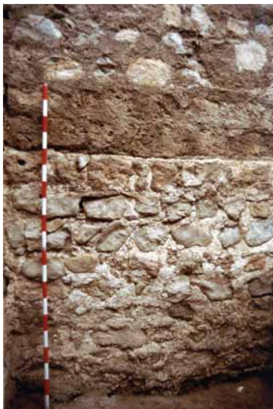
Sondeo 15 (Z5). Lienzo 11. Detalle de fase andalusí de época omeya, con mampuestos trabados con yeso, a la que se superpone fábrica bajomedieval.
