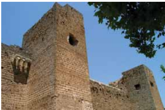
Fachada principal del castillo (siglo XV). Torres 2 y 3.
