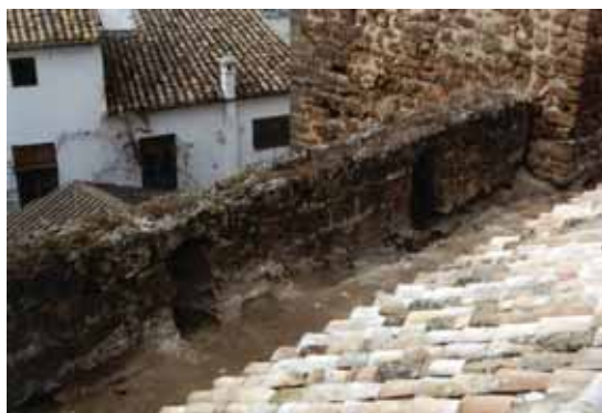
Lienzo 8. Parapeto original (siglo XV) conservado en su práctica totalidad, con troneras habilitadas para la artillería de fuego. Los indicios en estratigrafía muraria apuntan a que no se construyó merlatura alguna sino una albardilla a dos aguas continua.
