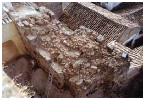
Torre 5. Estado al término de los trabajos de limpieza y desescombro.
