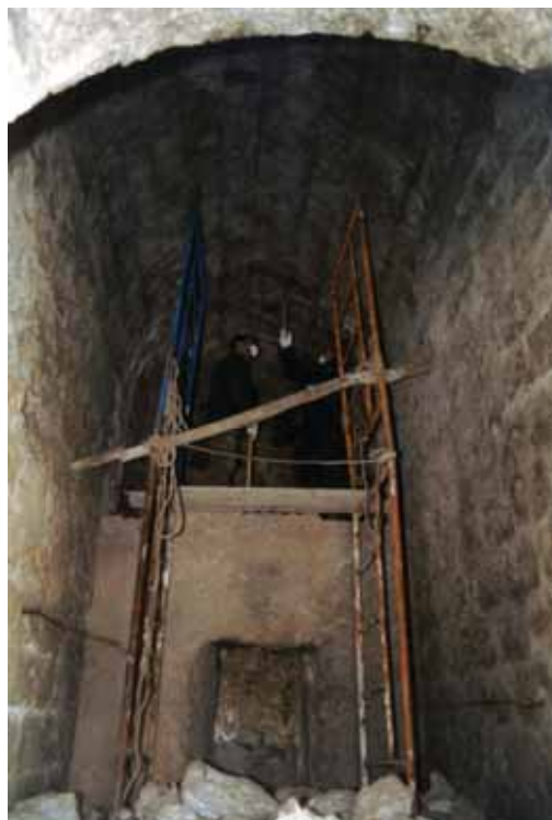
Torre 2. Interior durante el derribo de las estructuras postmedievales parasitarias de la obra medieval.
