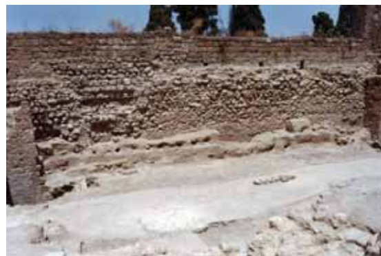
Zona 7. Lienzo 4. Muralla calatrava de mampostería (1246-1327) engrosada, en una fase posterior, bajomedieval, con tapial.
