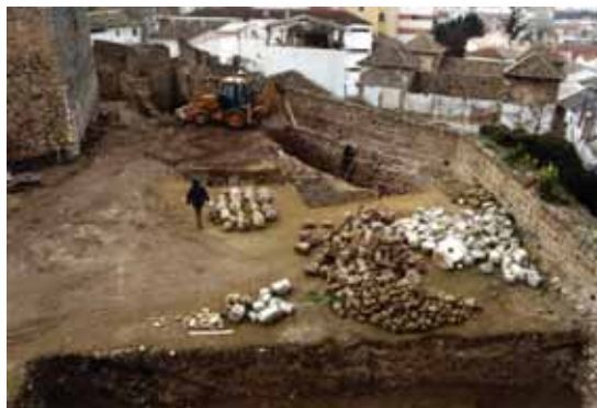
Zona 7. Panorámica general del lado oeste de la Zona 7 (Lienzo 9) y su continuación hacia las Zonas 4, 5 y 6. Antes de la intervención.
