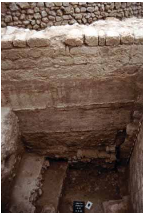
Sondeo 15 (Z5). Lienzo 12. Superposición de fábricas bajomedievales cristianas: sillares sobre encofrado del que se conservan dos cajas de su alzado mas la cimentación.
