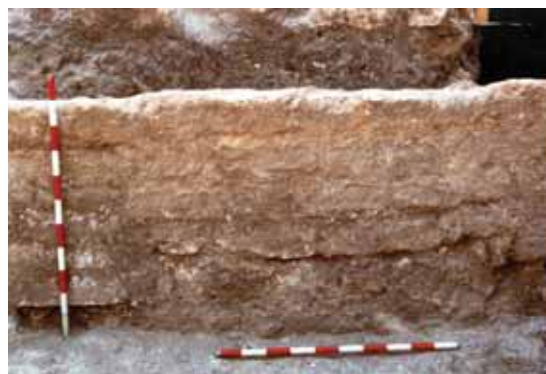
Zona 5. Lienzo 11. Detalle de la fase bajomedieval cristiana, con sillaretes con juntas de mortero repasadas con líneas incisas.
