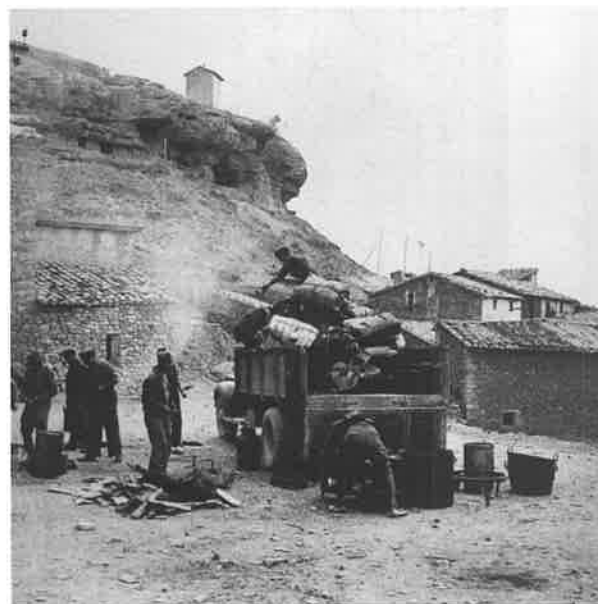
Monroyo (Teruel). Los soldados de recuperación preparan su rancho. (Monroyo, R. 1/5)
