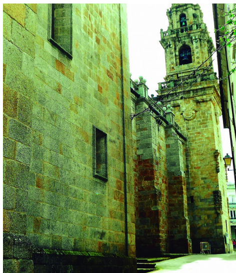
Fig. 25.- Muro norte de la catedral, desde el extremo del brazo del crucero hasta la fachada occidental. (Archivo Ramón Yzquierdo Perrín).
