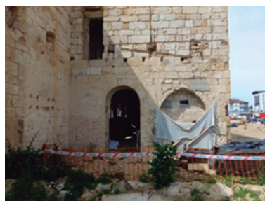
46.- Detalle del estado actual de las paredes norte y oeste del crucero del lado del evangelio de la iglesia. En la parte izquierda de la imagen, pared oeste, debió estar situado el arco de la capilla de Veracruz (Nº 21) el cual extrañamente no se observa.
