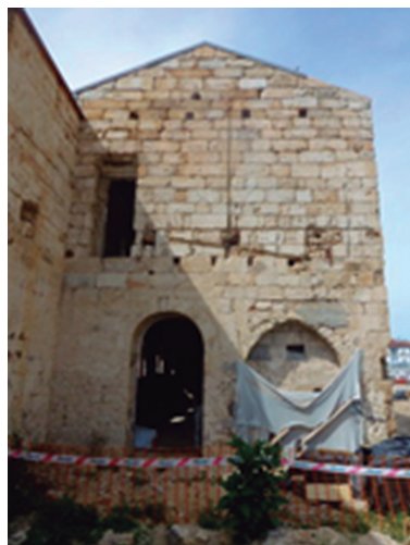
45.- Estado actual de las paredes norte y oeste del crucero del lado del evangelio de la iglesia, donde aun se puede observar de derecha a izquierda los arcos de las antiguas capillas de san Luis (Nº 19) y Ecce Homo (Nº 20)
