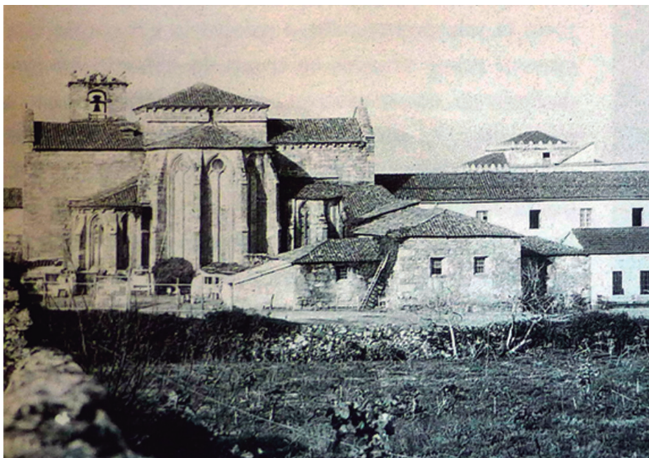
61.- Fotografía antigua del lado este de la iglesia en la que podemos ver en su posición original el exterior de su cabecera. De izquierda a derecha capilla absidial de Nra. Señora (Nº 12), capilla mayor (Nº 13), capilla absidial de san Bernardino (Nº 16) y junto a esta un edificio cuadrado con dos ventanas en su frente que esta unido al crucero del evangelio de la iglesia y que se trata posiblemente de la sacristía (Nº 18). Fuente Archivo Militar de Segovia, publicada en obra citada O templo de san Francisco de Ourense , Francisco Fariña Busto.
