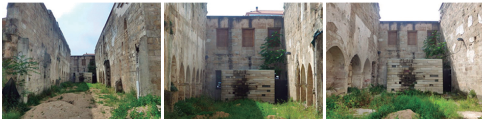
2-3-4.- Vista general del estado actual de la iglesia original en el barrio de san Francisco, donde a pesar de su estado de abandono se pueden observar numerosos restos de arcosolios funerarios y capillas.
