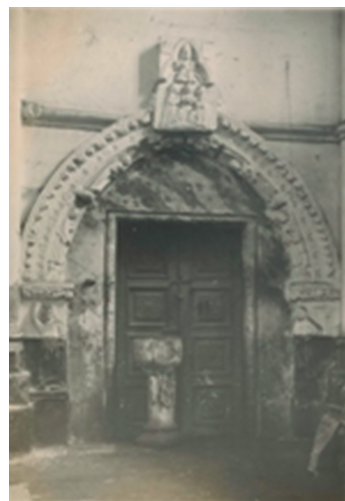
30.- A.F.Dep.OU., fondo Blanco Amor, fotografía antigua en la que se puede ver en su estado original el arco que separa la capilla mayor de la absidial de la epístola (Nº 12), que en aquel momento se encontraba cerrado por una puerta.
