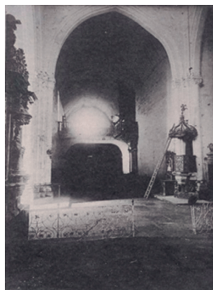
1.- Fotografía antigua de la nave principal de la iglesia en su estado original antes de su desmante y abandono en la década de los años 20 del siglo pasado. A pesar de la escasa calidad de la misma aun es posible hacerse una ligera idea de su configuración. Al fondo podemos observar el coro alto y el órgano situado en la parte de derecha o lado del evangelio. Fuente obra citada, Doroteo Calonge, Los tres conventos de san Francisco de Ourense .
