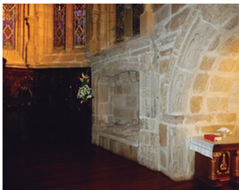
33.- Nueva iglesia de los franciscanos de Ourense, detalle de la pared del lado de la epístola de la capilla mayor, en el que se pueden ver de izquierda a derecha el arcosolio funerario de Juan de Novoa y parte del arco que la comunica con la capilla absidial de Nuestra Señora (Nº 12).
