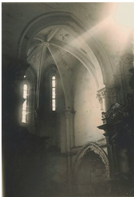
38.- A.F.Dep.OU., fondo Blanco Amor, fotografía antigua de la capilla la capilla de san Bernardino (Nº 16) y arco de comunicación con el altar mayor.
