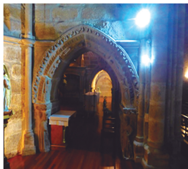
41.- Nueva iglesia de los franciscanos de Ourense, otra vista en detalle del arco que separa la capilla de san Bernardino (Nº 16) del altar mayor.
