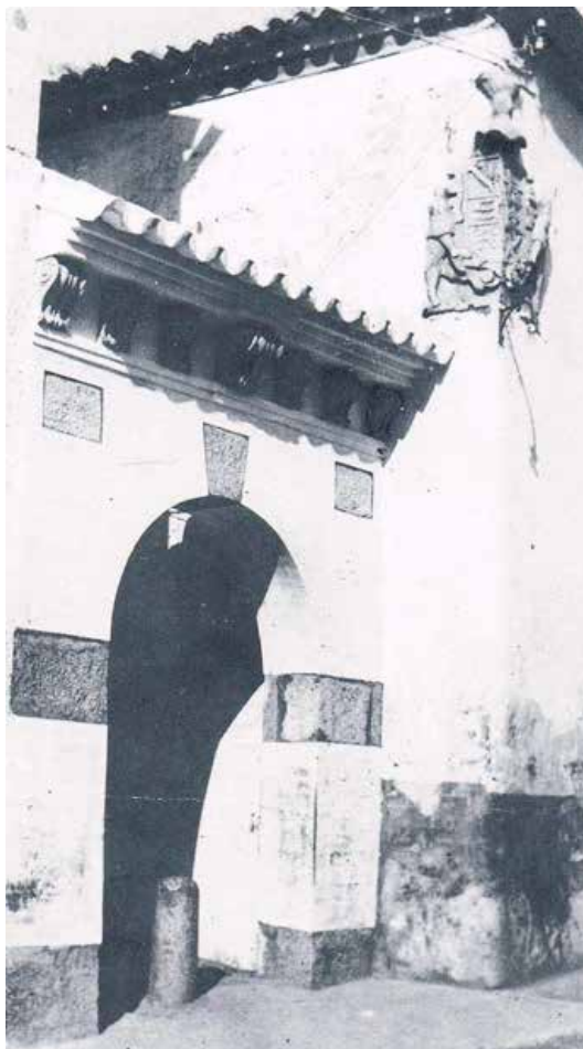
Casa del Marqués de Lorenzana en la calle Alzada. El oficio de vivir.
