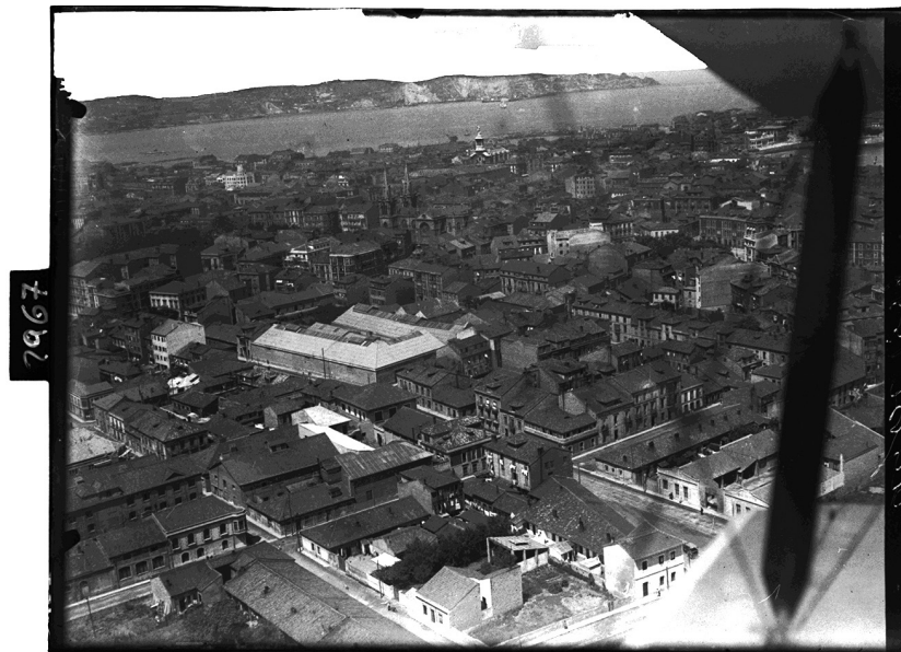
Fig. 5. Vista aérea del barrio de El Tejedor en 1931, donde se aprecian las instalaciones en forma de U del complejo de Tomás Zarracina. Muséu del Pueblu d'Asturies. Referencia: CS (FF002967). Autor: Constantino Suárez Fernández
