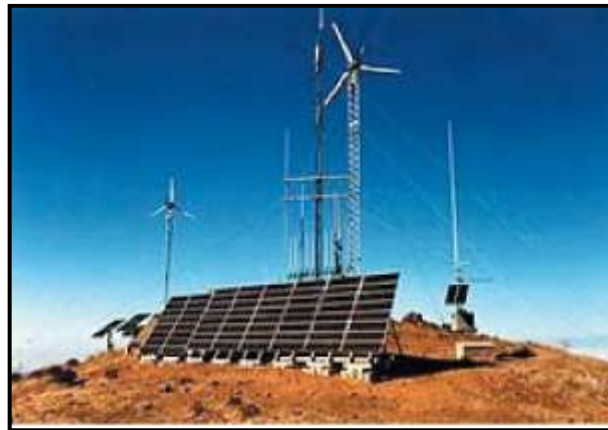
Fig.22: Aplicación en la estación de telecomunicaciones
