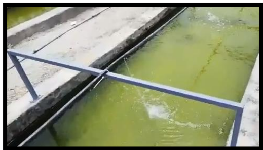
Figura 8. Sistema de Oxigenación por gravedad
