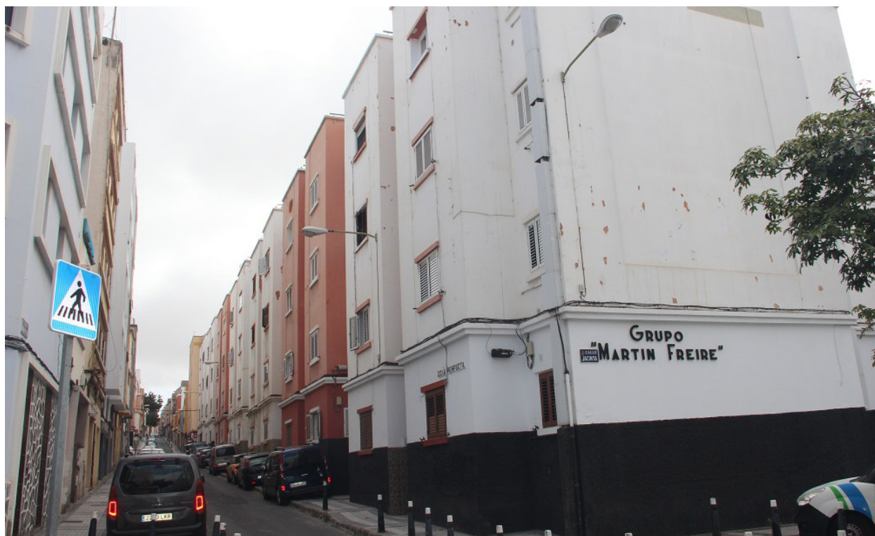
Figura 1. Imagen perteneciente al conjunto de 1472 viviendas del Grupo Martín Freire, Schamann, Las Palmas de Gran Canaria. Fuente: Fotografía del autor.
