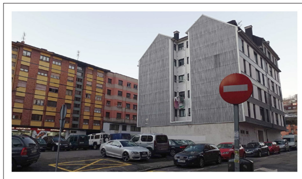
FIG. 7. Solar que albergó las instalaciones de los Talleres Soldevilla en Sama de Langreo, actualmente destinado a espacio de aparcamiento. Fotografía de la autora.
