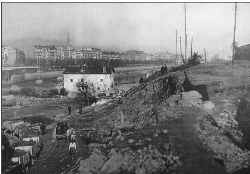
Encauzamiento del Urumea en los terrenos del molino de marea “errotatxiki”, hoy emplazamiento del puente de Mundaiz
