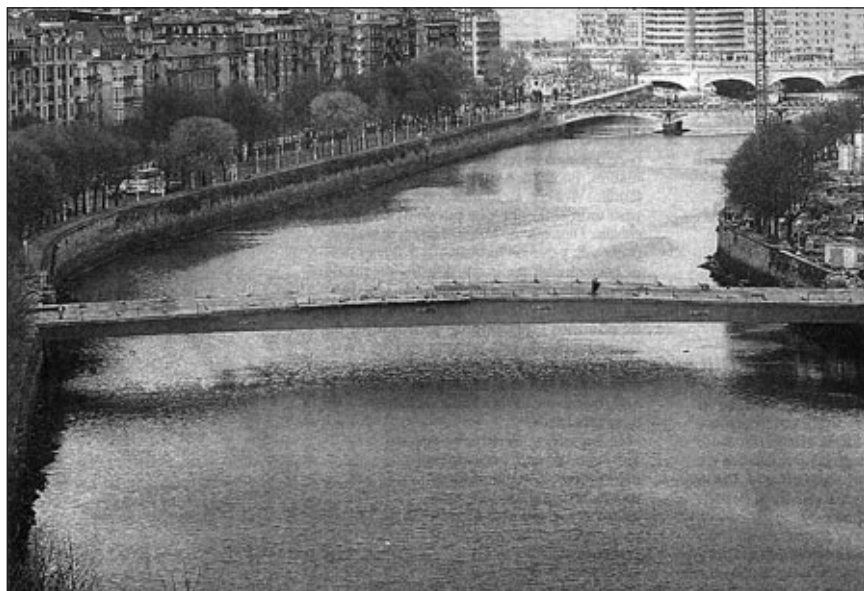
(CLL) El puente ya colocado, a falta de últimos detalles
