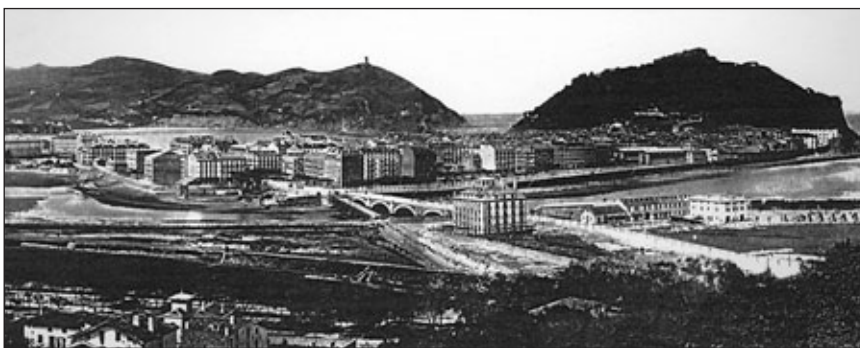
(BZ) San Sebastian en 1872. El puente de Santa Catalina de madera enfila la carretera vieja. El nuevo puente de piedra se dirigió hacia la nueva carretera dirección a Pasajes
