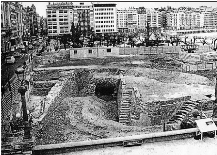
(AK) Todo el conjunto arquitectónico que rodea el arco y la plaza de Armas será conservado y expuesto al público
