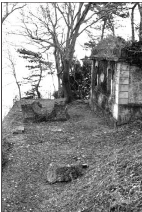
Galería de tiro. Vista tomada desde la parte superior del túnel hacia la plataforma de tiradores. El edificio de la derecha es el pabellón de abrigo y guardablancaos
