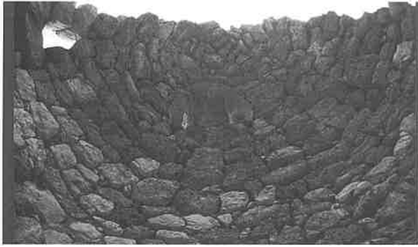
Nevera de Cuevas de Cañart. Bóveda de aproximación de hiladas de piedra compuestas por tobas calcáreas (24/10/98).
