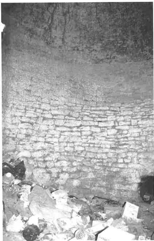
Vista interior de los muros de mampostería del pozo de nieve de Valdealgorga y abertura del túnel de acceso inferior, apreciándose restos de vertidos arrojados a través de la abertura lateral (25/08/98).
