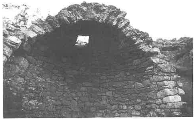
Sección de la pared, acceso superior y bóveda de mampostería en seco del pozo de nieve de Cuevas de Cañart (24/10/98).
