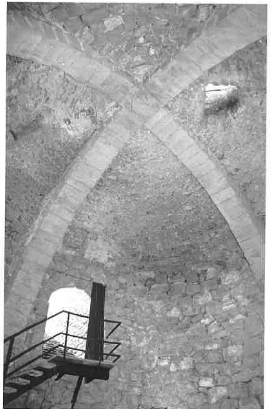
Bóveda con dos arcos cruzados de medio punto, acceso actual artificial y abertura superior cenital de la nevera urbana de Belmonte (06/06/98).
