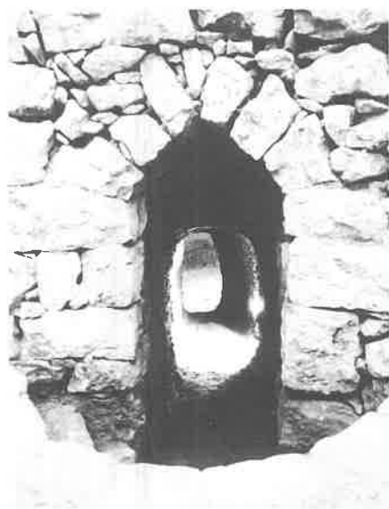
Nevera urbana de Belmonte. Aspecto del interior del profundo y accesible túnel de desagüe y pozo ciego final (agosto 1993).
