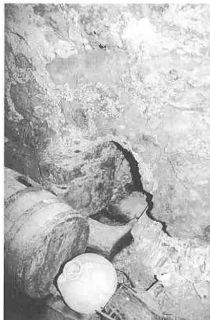
Detalle del posible túnel de desagüe, actualmente cegado, del depósito de nieve urbano de Torrevellilla (07/11/98).
