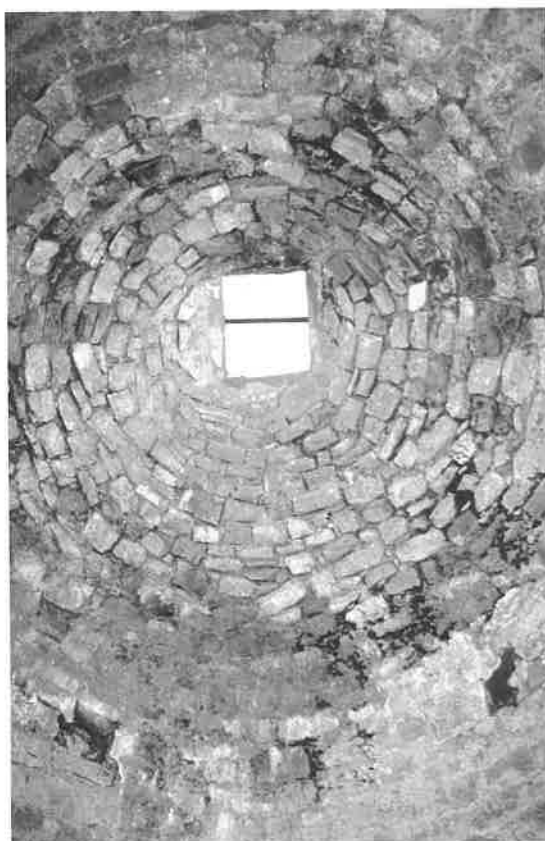
Falsa bóveda de aproximación de hiladas de piedra y abertura cenital de la nevera urbana de Cañada de Verich (06/06/98).
