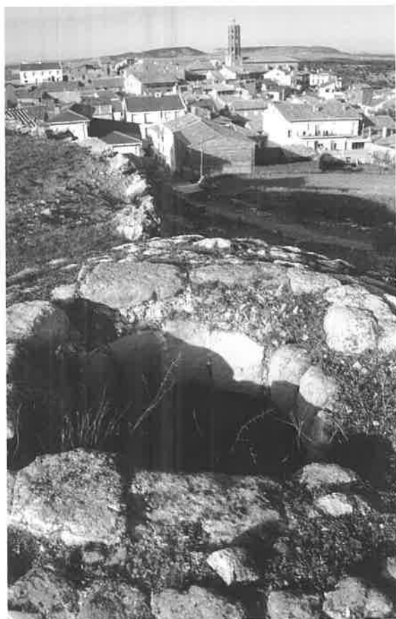
Emplazamiento en relación a la localidad y detalle de la abertura superior cenital de la nevera urbana de La Mata de los Olmos (07/11/98).
