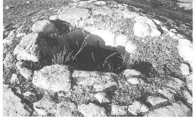
Nevera de la Mata de los Olmos. Abertura superior cenital, de forma circular, y aspecto exterior de la bóveda de mampostería (07/11/98).
