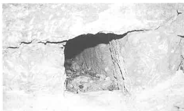
Abertura en el muro del pequeño arbellón de desagüe de la nevera de Cañada de Verich (06/06/98).
