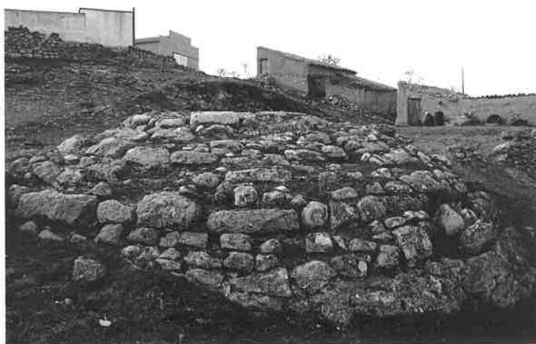
Bóveda de cañón realizada en piedra, empleada como sobrecubierta de la abertura cenital de la nevera de Arnes (Tarragona) (03/07/98).
