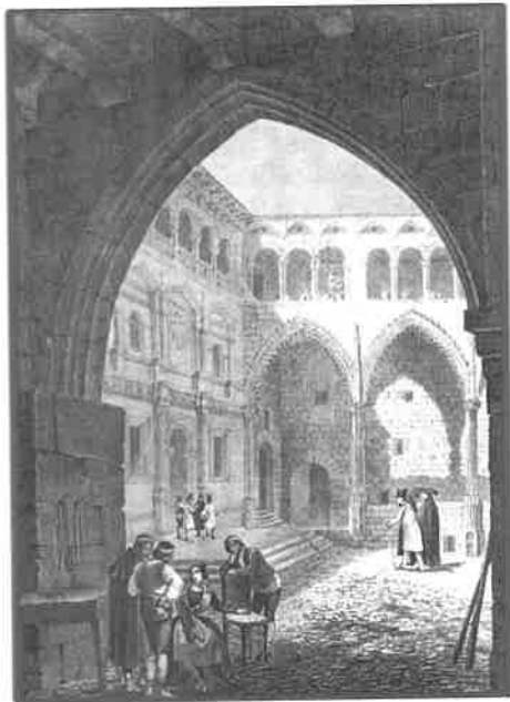
El ayuntamiento, la lonja y la plaza de España de Alcañiz a mediados del siglo XIX, según una ilustración de una litografía de F.J. Parcerisa, fechada en diciembre de 1844. En el subsuelo, estaba situado el almacén de nieve o hielo que se utilizaba como nevería, la cual en dicha fecha todavía se encontraba en funcionamiento.
