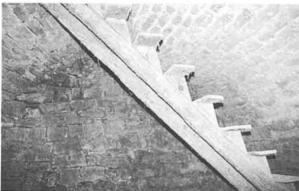
Vista interior de la atípica nevera urbana de Cretas. Pared lateral de soporte de la bóveda de cañón y actual escalera de madera de acceso al depósito. (03/07/98).
