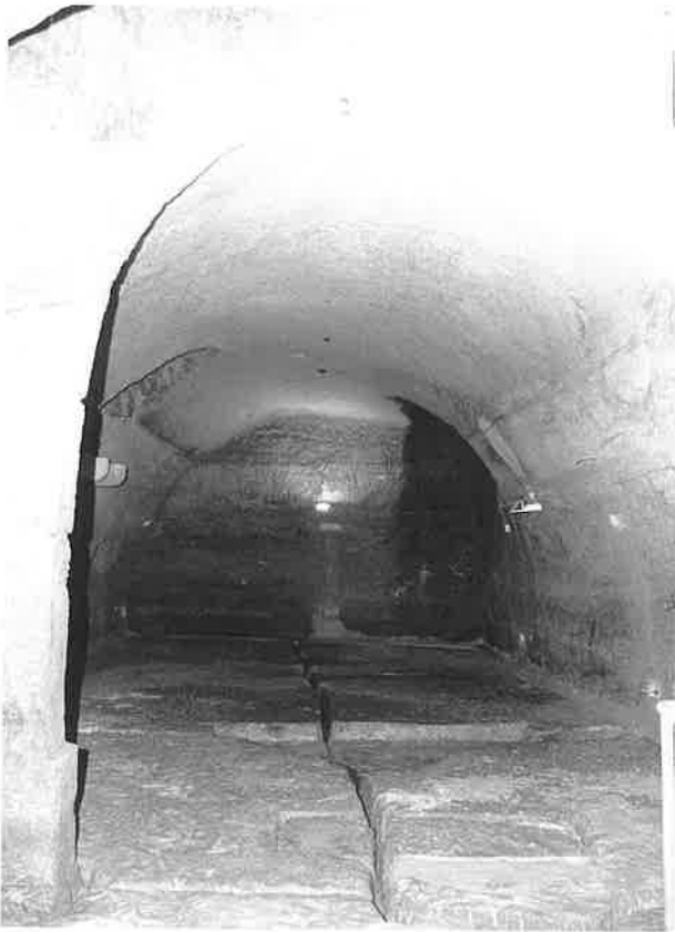
Nevería de Alcañiz. Bóveda de cañón excavada en la roca, en la zona de ampliación del recinto subterráneo y red de canalillos que formaban parte del sistema de drenaje.
