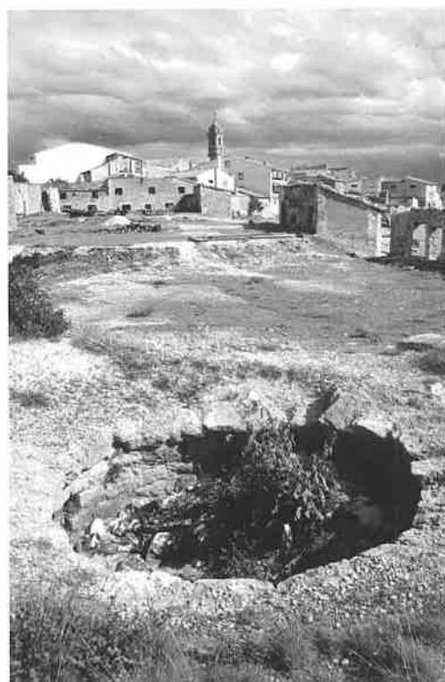
Vista exterior de la bóveda semiexenta, por aproximación de hiladas de piedra, de la nevera urbana de La Mata de los Olmos y abertura lateral (07/11/98).
