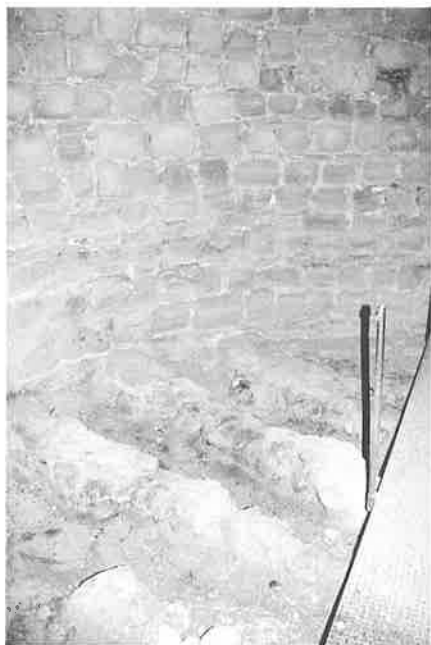
Muretes paralelos del sistema de drenaje empleado en el antiguo pozo de nieve de Albalate (06/06/98).
