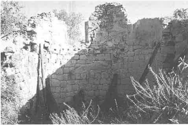
Aspecto de los muros de piedra sillar de la antigua nevera de La Fresneda y abertura lateral de acceso (04/07/98).
