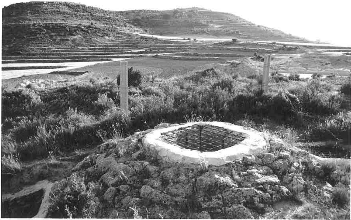
Situación geográfica y aspecto exterior de la nevera de aprovisionamiento de Alloza, apreciándose el cierre de la bóveda y sus tres accesos superiores, compuestos por dos aberturas laterales rectangulares y un acceso central de forma circular (10/07/98).
