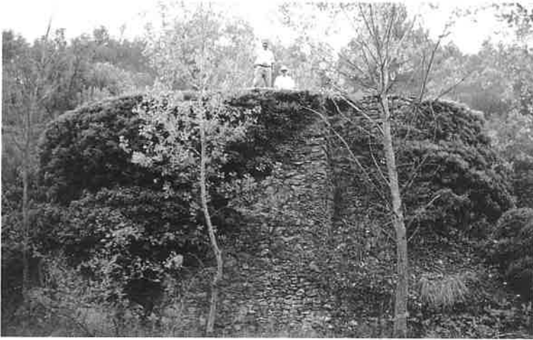
Situación de la nevera del "Forcall" (Fórnoles). Vista de las paredes de piedra que actúan como contrafuerte exterior del pozo (11-12/09/98).
