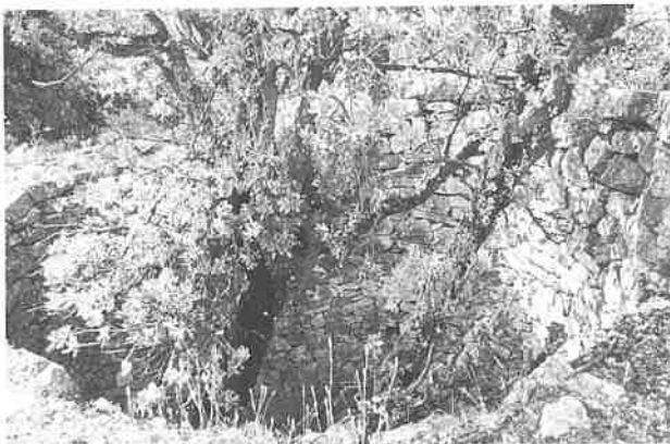
Vista general del paramento de piedra del antiguo depósito de nieve del "Mas de Borla" (Peñarroya de Tastavins), con una carrasca crecida en su interior (18/07/98).
