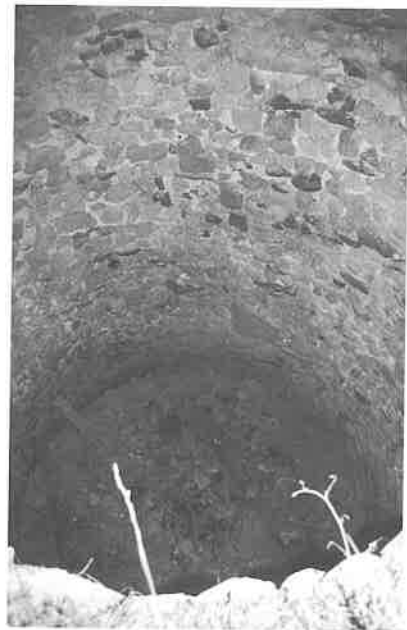
Vista interior del pozo de nieve del Convento del Olivar (Esteruel), cuyas paredes están realizadas en mampostería, ajustada con mortero de cal (10/10/98).
