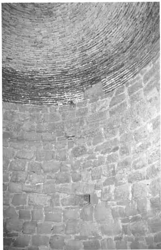
Vista interior de las paredes de sillera del depósito y arranque de la bóveda de ladrillo de la nevera urbana de Albalate (06/06/98).
