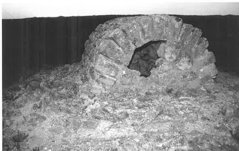
Bóveda de cañón realizada en piedra, empleada como sobrecubierta de la abertura cenital de la nevera de Arnes (Tarragona) (03/07/98).
