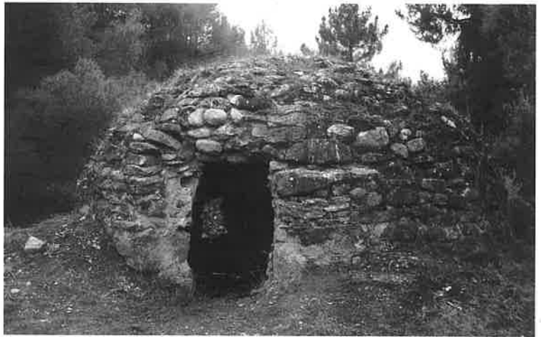
Situación de la nevera del "Forcall" (Fórnoles). Vista de las paredes de piedra que actúan como contrafuerte exterior del pozo (11-12/09/98).
