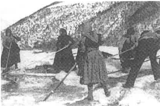
Labores de troceado del hielo con ganchos y palancas en balsas empleadas para la fabricación natural del producto (de "Els pous de glaç de la comarca de Bages" de Jaume Perarnau).
