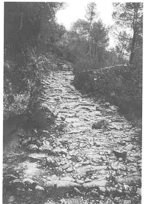
Senda empedrada de herradura que transita junto a la nevera del "Forcall" (Fórnoles), la cual debía permitir el transporte de los "panes" de hielo a lomos de caballería (marzo, 1999).
