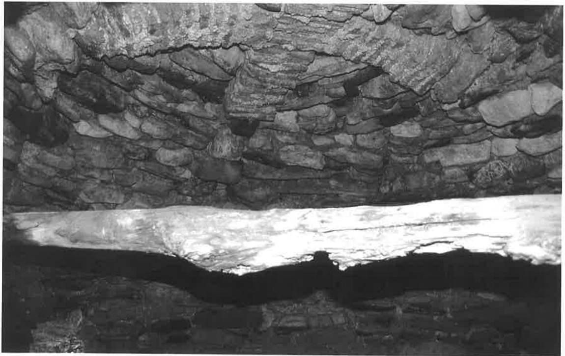
Aspecto interior de la bóveda de aproximación de hiladas de piedra, cruceta central de ladrillo y travesaño de madera de la nevera del Convento del Olivar (Estercuel) (10/10/98).
