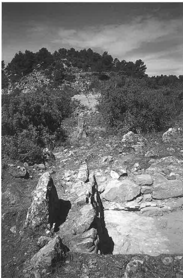
Fig. 63. El Cerrao. Muro M 1 visto desde el este, en el sondeo S 1 de la zona D. La zona E se ve al fondo, en lo alto.
