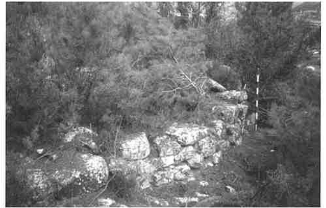
Fig. 131. Muro de cierre curvilíneo al extremo Sureste del caserío de Vall d'en Jorba (Valldeltormo).
