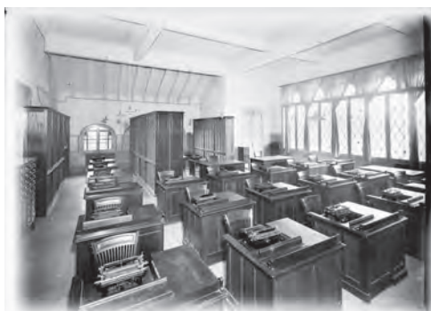
4 SEDE DE LA EMPRESA NORTEAMERICANA R.G. DUN & CO. EN EL CUARTO PISO DEL CASAL DEL ESTALVI. LA ESTRUCTURA DE HORMIGÓN ARMADO DE LA CUBIERTA QUEDA VISIBLE EN LOS ESPACIOS ALQUILADOS. [FONDO BRANGULÍ, ANCI-42-N-9459, ANC].
