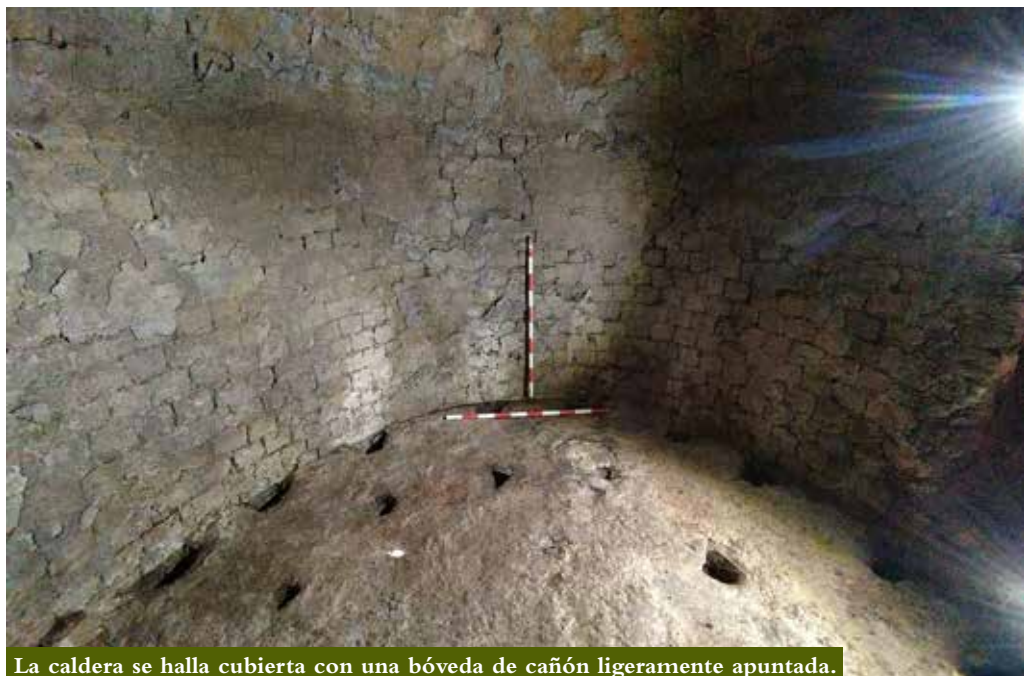
La caldera se halla cubierta con una bóveda de cañón ligeramente apuntada.
