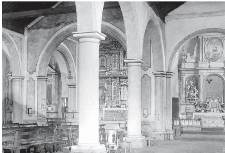
Figura 9: Interior de la iglesia parroquial de San Blas antes de la reforma de mediados del siglo XX; se aprecia la policromía interior de los tres retablos de las capillas de la cabecera y la decoración de mármoles fingidos
