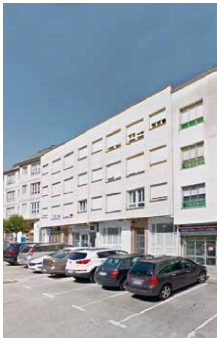
Fig.10. Alzado principal do edificio residencial en Saavedra Meneses (arquivo fotográfico da autora).
