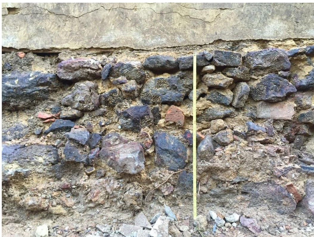
Figura 2: Imagem do perfil estratigráfico da parede externa ao pátio interno do Casarão da Ladeira do Castelo.
