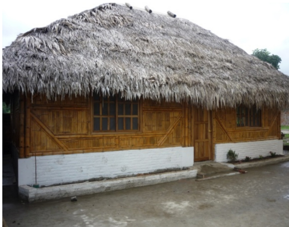
Foto 5. Aula ecológica construida por los artesanos capacitados
