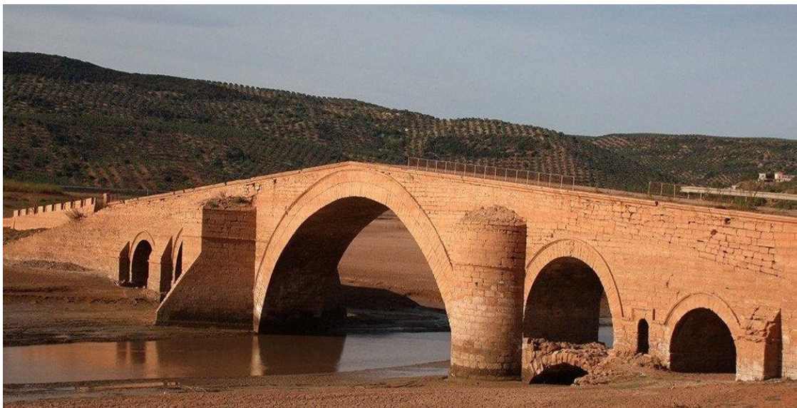
Puente Ariza (Úbeda).
