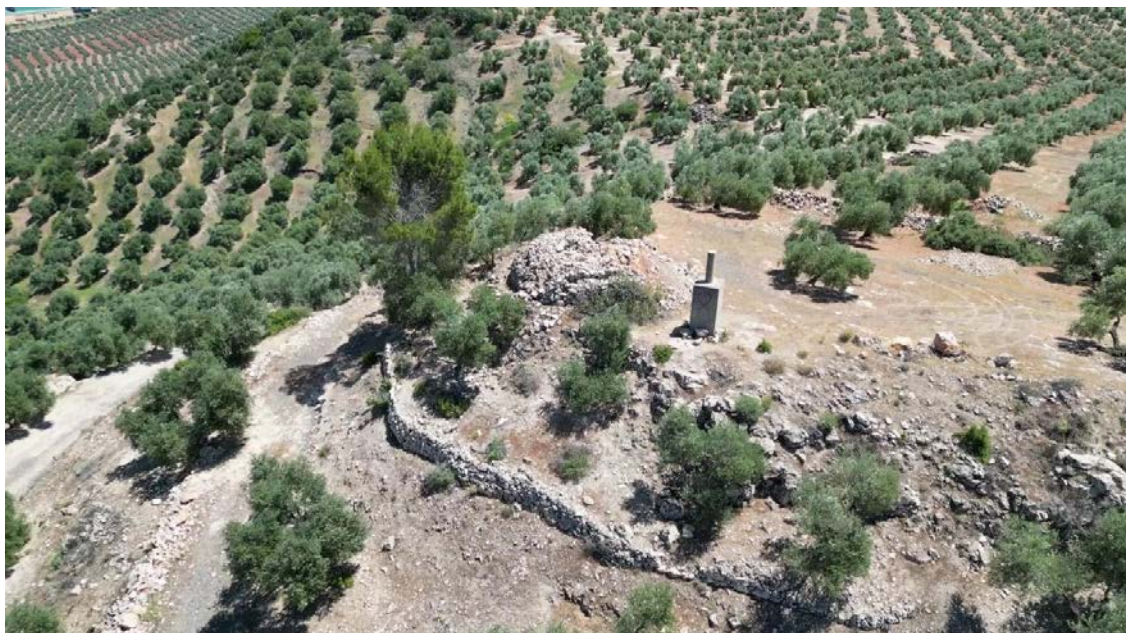
Restos de la Torre de las Monjas (Navas de San Juan).
