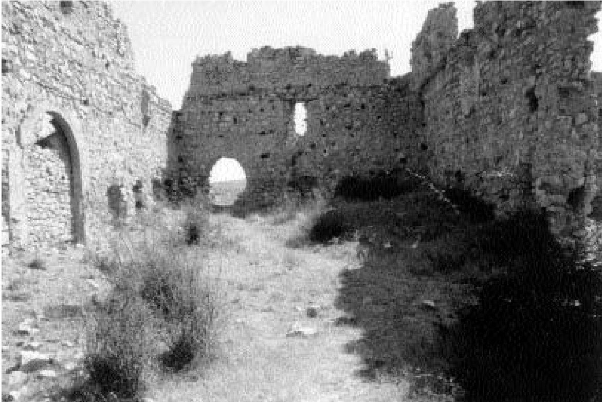
1. Iglesia de San Miguel antes de la excavación.
