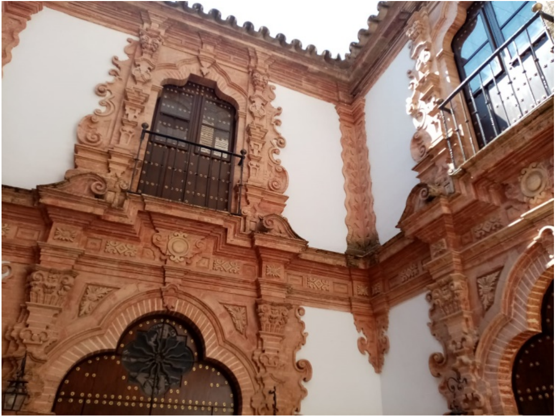
Fig. 5.- Casa construida por la familia Orduña, detalle del patio, Écija, Sevilla 33 .
