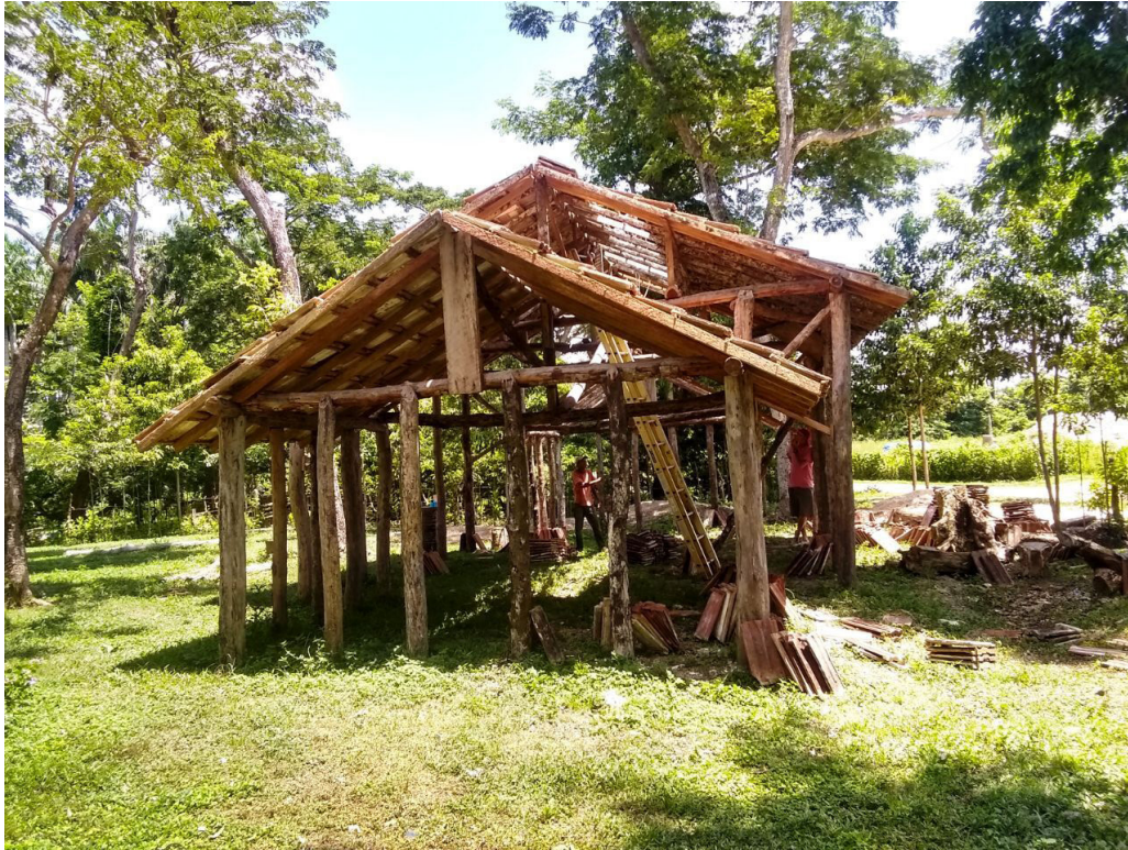
Figura 10. Los vecinos de La Picadora construyendo la biblioteca comunitaria, 2019
