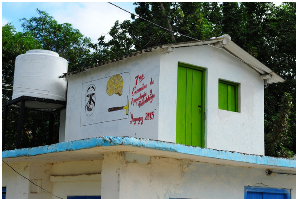
Figura 8. Vivienda con techo de tejas de fibrocemento. La Picadora, 2015
