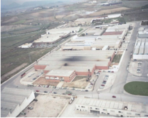
INDUSTRIAS ESTEBAN: instalaciones de Industrias Esteban en Landaben. (1974). Fototeca del Archivo General de Navarra. ES/NA/AGN/F432/FOT_FOAT_3951
