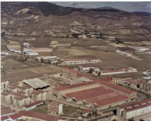
MATESA: Instalaciones industriales en Pamplona (1968). Fototeca del Archivo General de Navarra. ES/NA/AGN/F432/FOT_FOAT_3857
