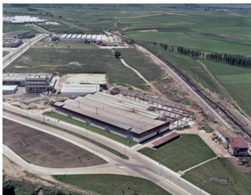
IBÉRICAS DEL FRÍO: Instalaciones industriales de Koxka en Landaben(1972). Fototeca del Archivo General de Navarra ES/NA/AGN/F432/FOT_FOAT_3756
