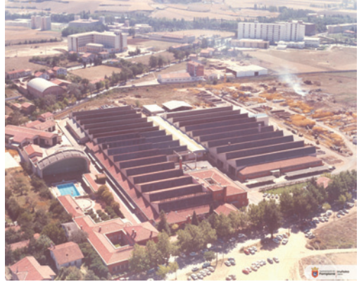
IMENASA: Instalaciones y sectores anejos (1973). Fototeca del Archivo Municipal de Pamplona. AMP002639
