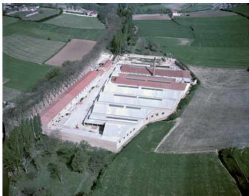
CHALMETA: Instalaciones industriales de Aitona, Chalmeta S.A., de Pamplona. (1966) Fototeca del Archivo General de Navarra. ES/NA/AGN/F432/FOT_FOAT_3820
