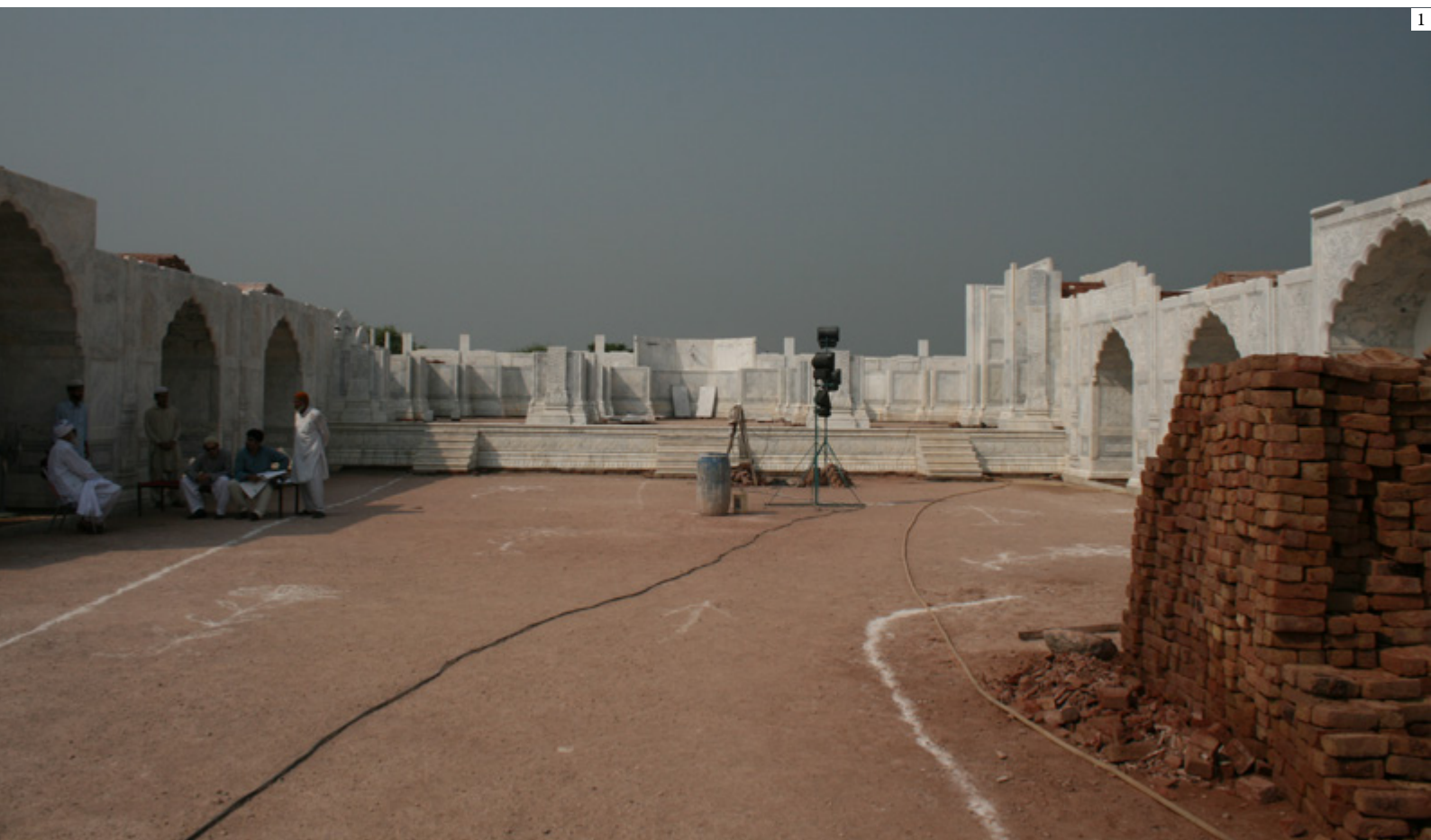
1: Interior courtyard during construction 2: South-side interior niches 3: Column detail | 1: Pátio interior en construcción 2: Nichos interiores del ala sur 3: Detalle de una columna | 1: Pátio interior durante a construção 2: Nichos interiores do lado sul 3: Pormenor da coluna (2,3: Raza Kazim)
