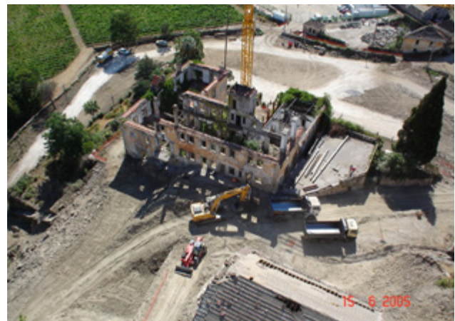
Refurbishment of the main building, with excavations to put part of the new program below ground while preserving the original facades where possible | Rehabilitación del edificio principal. Se realizaron excavaciones para soterrar parte del nuevo programa y se conservaron, donde fue posible, las fachadas originales | Reabilitação do edifício principal. Foram efetuadas escavações para enterrar parte do novo programa e as fachadas originais foram preservadas sempre que possível (Somague)
