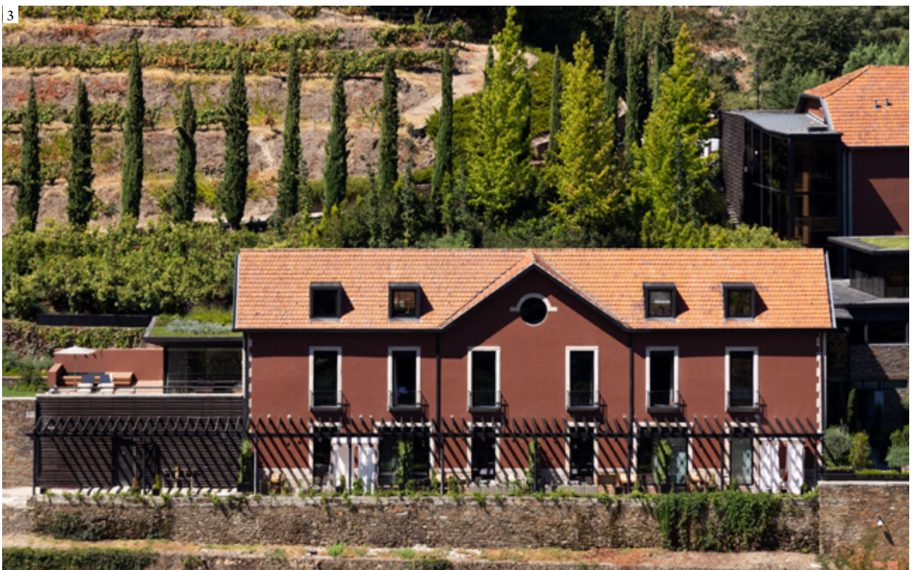
The so-called “business center” was transformed into various bedrooms, while maintaining the building’s original character | El conocido como “centro de negocios” fue transformado para alojar varias habitaciones. A pesar de ello, se mantuvo el carácter original del edificio | O chamado “centro de negócios” foi convertido para acomodar várias habitações. Apesar disso, o caráter original do edifício foi mantido (1, 2: Somague 3: Six Senses)
