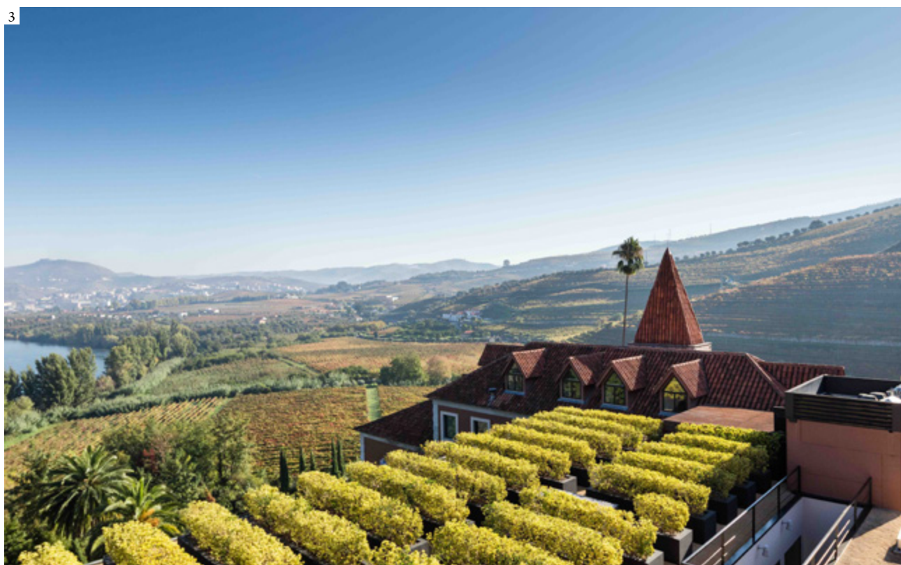
1, 2: Process of building the wooden roof structures 3: The garden terraces allow part of the added volumes to be “concealed” so as not to alter the original look of the quinta | 1, 2: Proceso de construcción de las estructuras de madera de la cubierta 3: Las terrazas ajardinadas permiten “ocultar” parte de los volúmenes añadidos, sin desvirtuar así la imagen original de la quinta | 1, 2: Processo de construção das estruturas de madeira da cobertura 3: Os terraços ajardinados permitem “esconder” uma parte dos volumes adicionais, sem prejudicar a imagem original da quinta (3: Six Senses)
