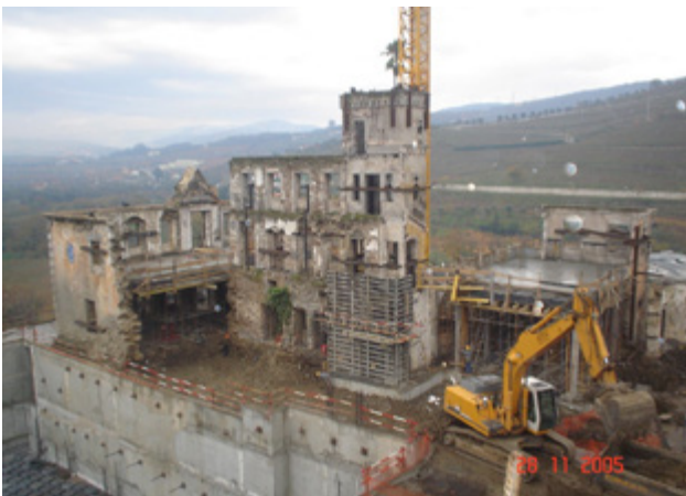
Refurbishment of the main building, with excavations to put part of the new program below ground while preserving the original facades where possible | Rehabilitación del edificio principal. Se realizaron excavaciones para soterrar parte del nuevo programa y se conservaron, donde fue posible, las fachadas originales | Reabilitação do edifício principal. Foram efetuadas escavações para enterrar parte do novo programa e as fachadas originais foram preservadas sempre que possível (Somague)
